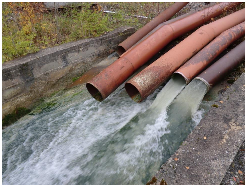
Joonis 1. Settebassein nr 4 pumbad (Foto: töö autor, 14.10.2014)
