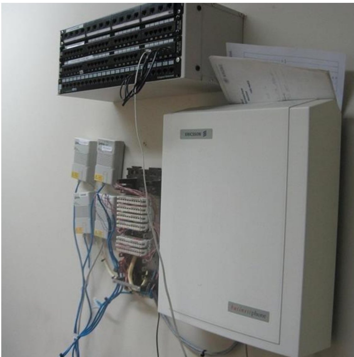
Joonis 2.1. Foto näidisasukohast.
