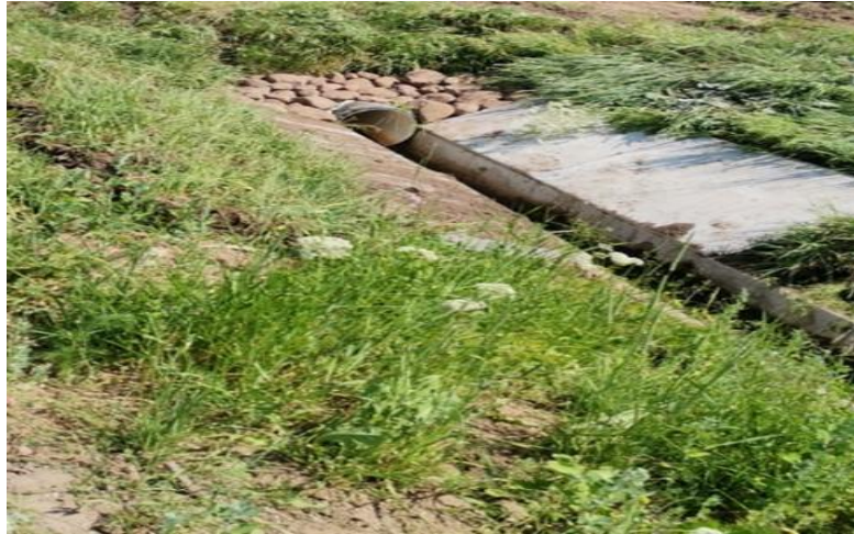
Pilt 2.8 Kindlustatud kraav betoonelementidega ja maakiviga [6]
