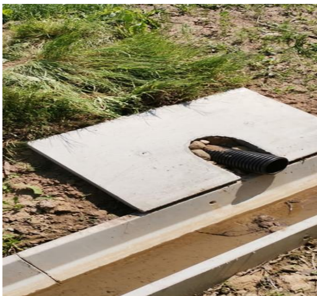
Pilt 2.7 Betoonplaat avaga 315 mm [6]
