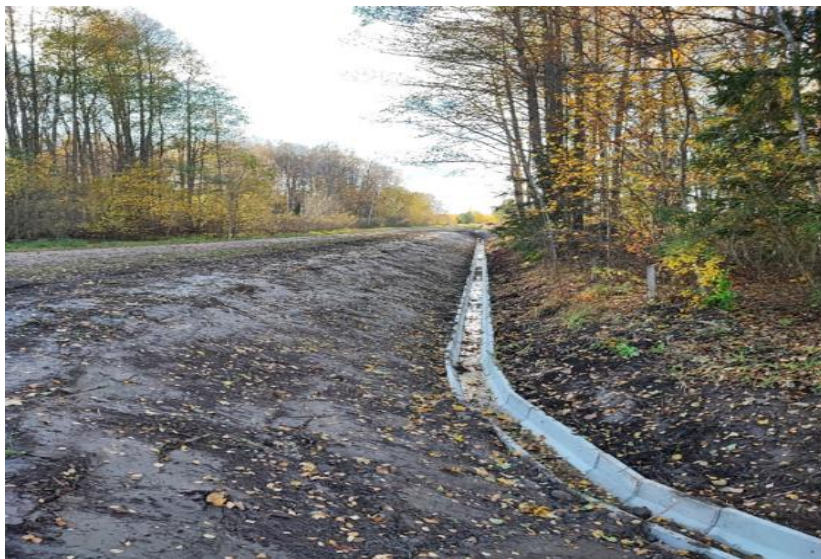
Pilt 2.6 Pärast betoonelementide paigaldamist kraavi ja tööde (Pildi autor Hardi Lüüdik, 19.10.2022, Pärnu maakond, Saarde vald, Leipste küla)
