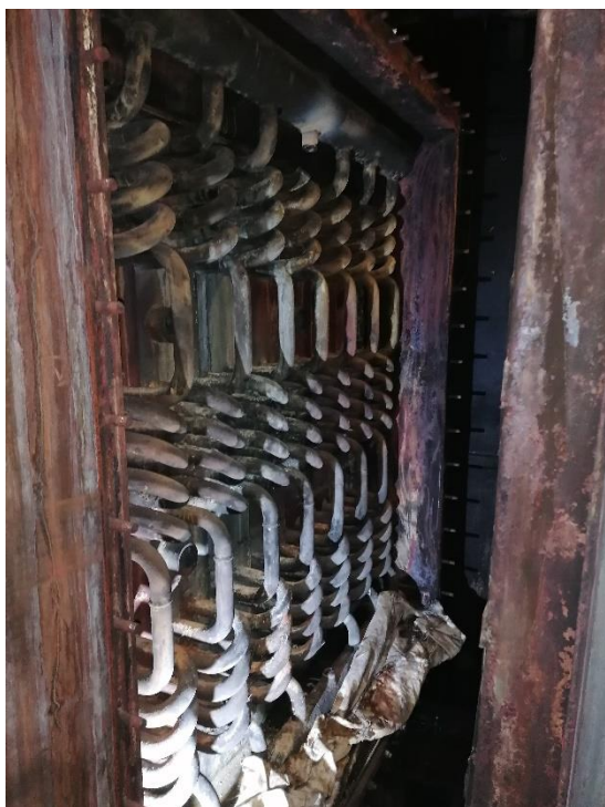
Joonis 14. Silja Europa 4. utiili torustik Autori koostatud
