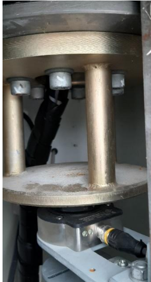
Joonis 3.8 Parabolantenni korpuse sisesed kaablid
