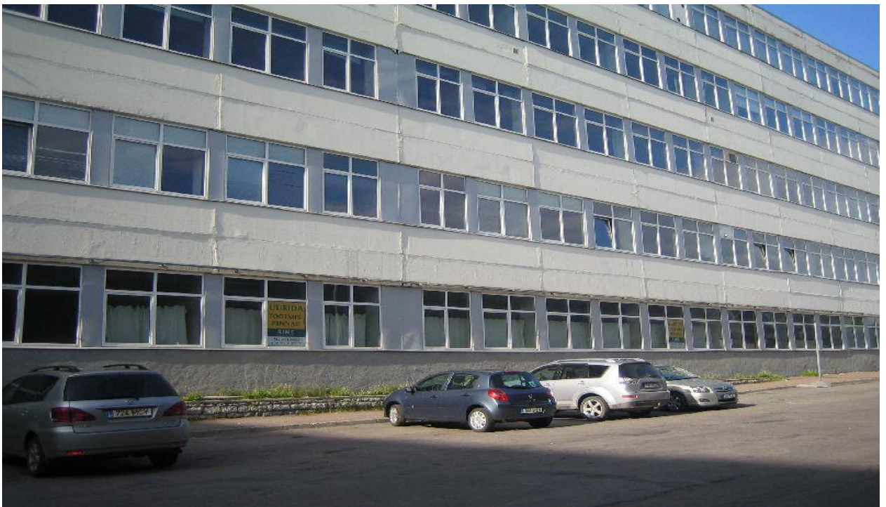
Joonis 9. Hoone väline seisukord enne 1. korruse arendust.
