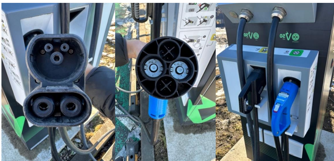
Joonis L4.1. Enefit Volti avalik laadimispunkt Tallinna piiril Laagris 50 kW võimsusega CHAdeMO ja 161 kW võimsusega CCS kiirlaadijatega
