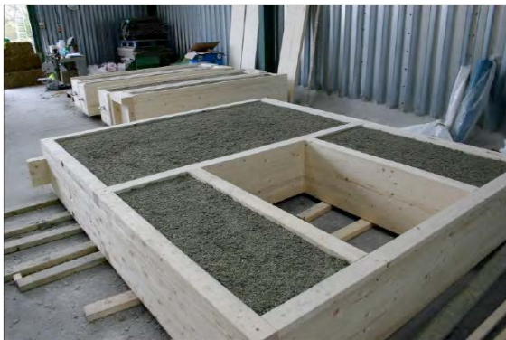
Joonis 9 Puitkarkass täidetud kanepilubjaga [7]
