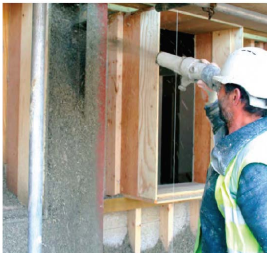
Joonis 7 Pihustamise meetod [7]
