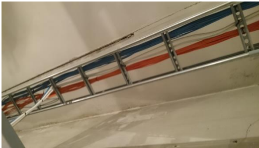
Joonis 3.13. Mõlemate süsteemide optikakaablid ühel redelil
