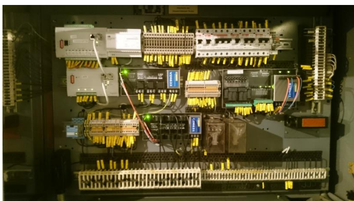
Joonis 3.9. Väljuva fiidri sekundaar klemmkapp
