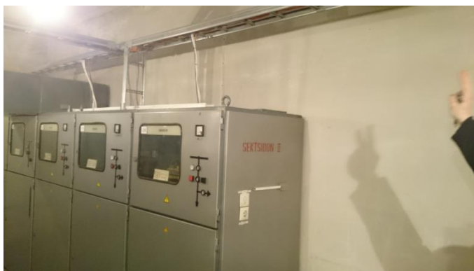
Joonis 3.7. AJ 808 keskpinge lahtrid
