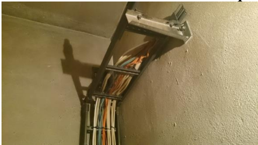
Joonis 3.13. Mõlemate süsteemide optikakaablid ühel redelil
