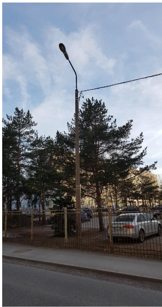
Joonis 1.10. Metallhalogeniid valgusti sarnaneb välimuselt naatriumvalgustiga
