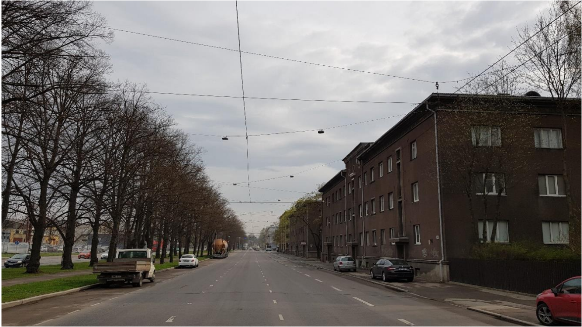
Joonis 1.7. Paldiski maanteel asendati kõrgrõhu-naatrium valgustid leedvalgustite vastu ja paljasõhuliin isoleeritud õhuliini vastu.
