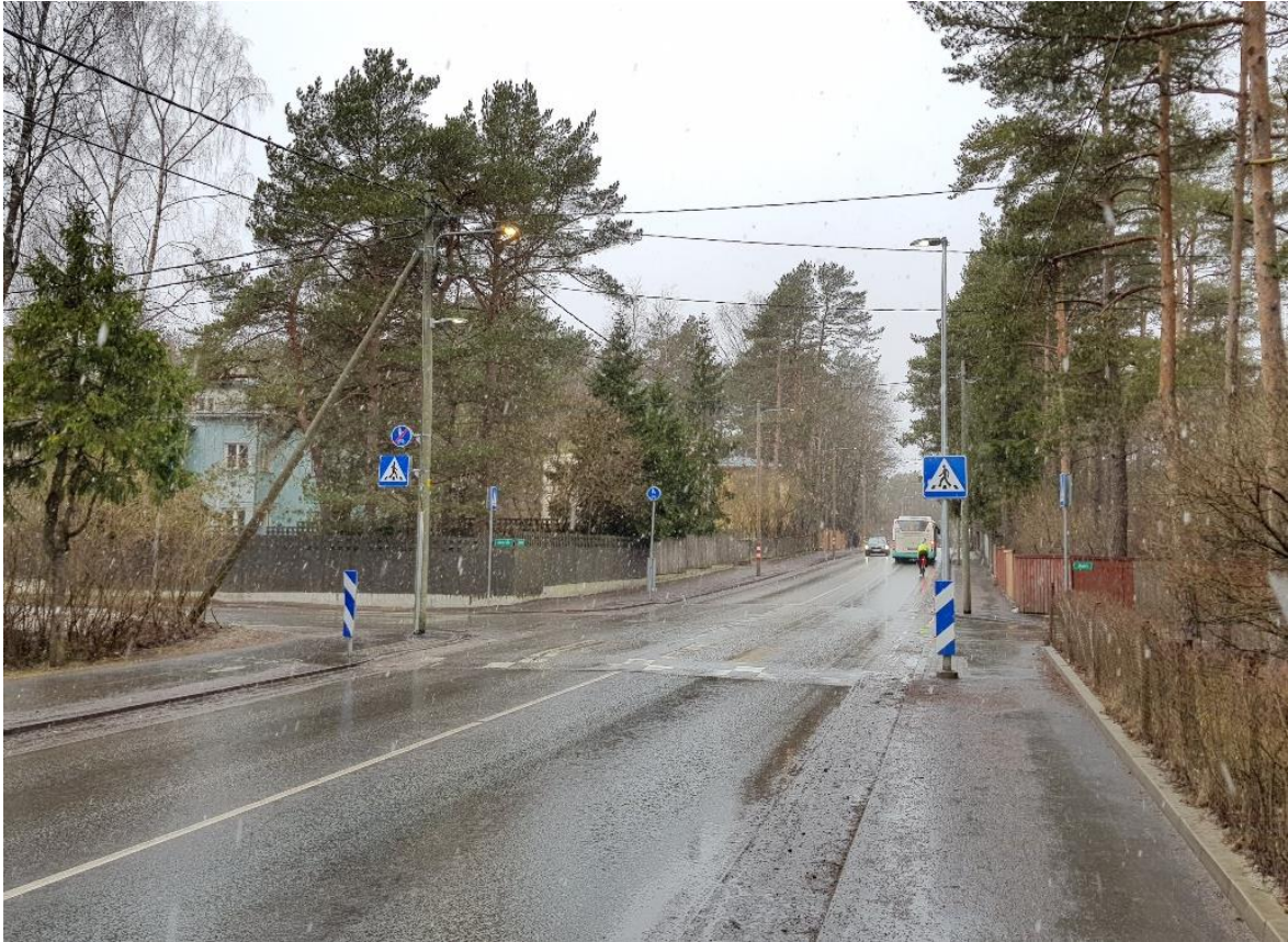
Joonis 1.6. 2018. aastal valminud Valdeku tänaval jäid alles Elektrilevi õhuliinid ja puitmastid, millele on paigaldatud ka uued leed tänavavalgustid
