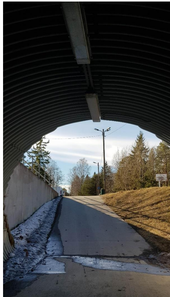
Joonis 1.14 Luminofoorlambid jalakäijate tunnelis
