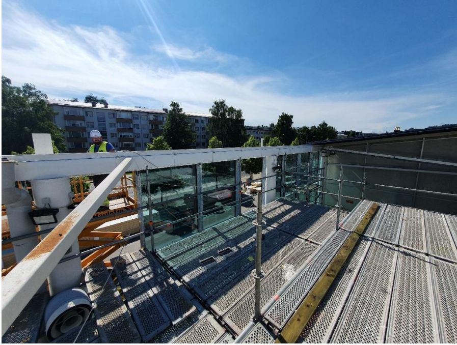
Joonis 3.16 Metalltalade paigaldus
