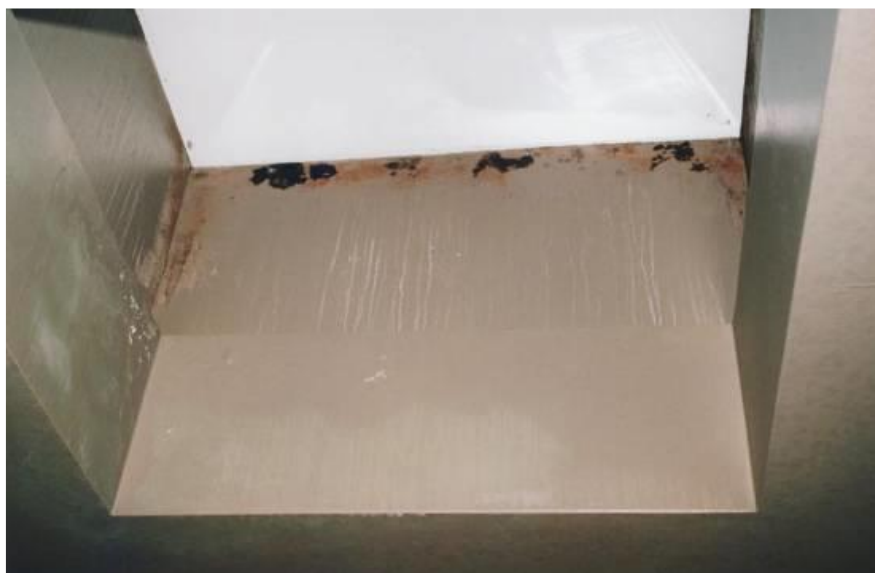
Joonis 1.6 Rikutud siseviimistlus valguskuplites saunaploki osas [2]
