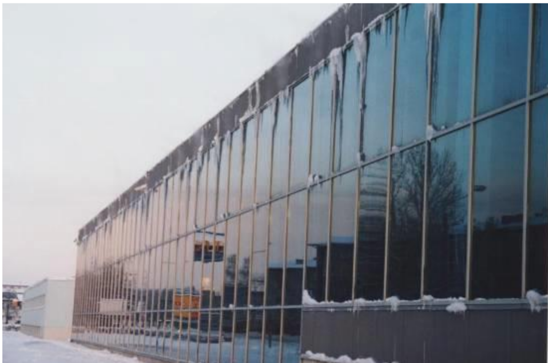
Joonis 1.5 Aura veekeskuse klaasfassaad Turu tn poolel [2]
