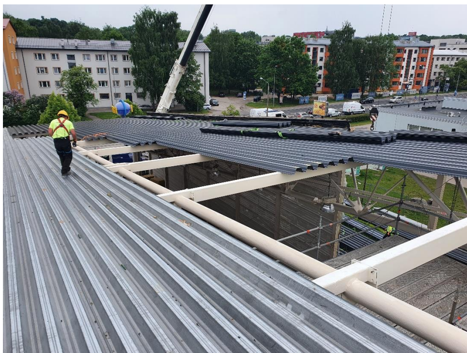
Joonis 3.8 Katuse kandeprofiilpleki paigaldus
