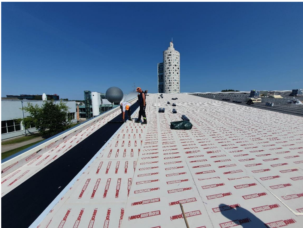
Joonis 3.28 Aluskatte paigaldus
