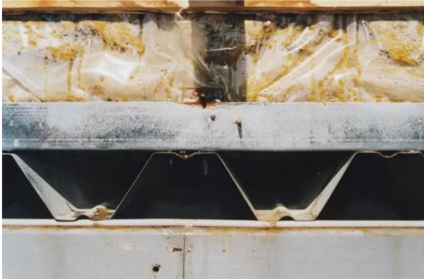
Joonis 1.9 Katuslae ja fassaadi liitekoht [2]
