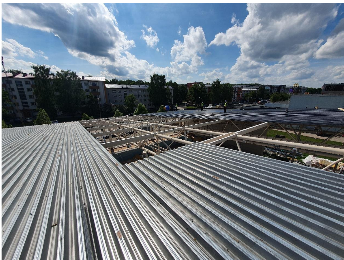
Joonis 3.10 Katuse lammutamine ja ehitamine üheaegselt
