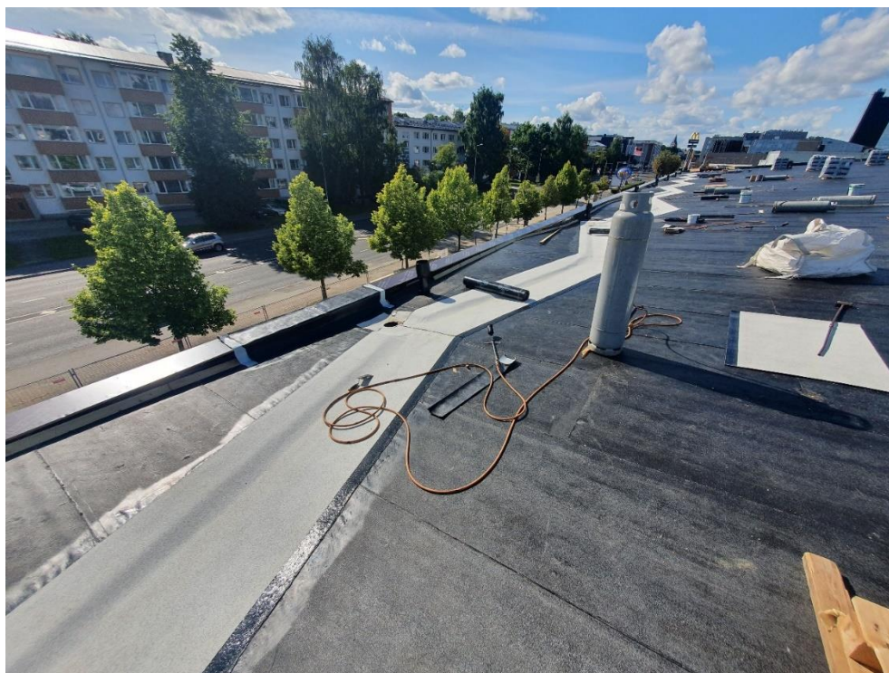
Joonis 3.30 Viimase katte paigaldus
