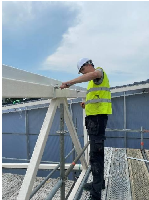
Joonis 3.12 Fermidele nelikanttorude paigaldamine
