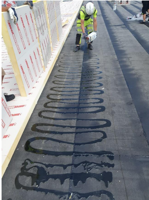
Joonis 3.25 Soojustuse liimimine
