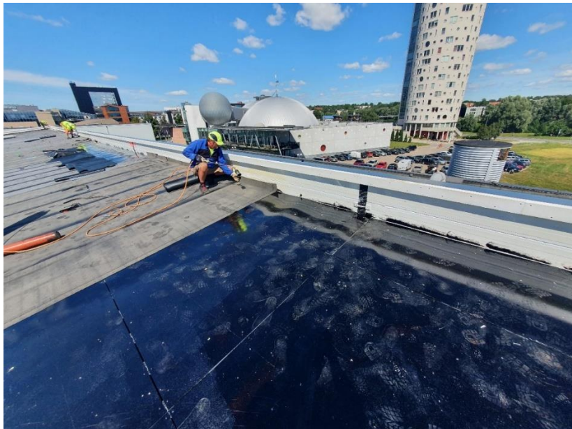
Joonis 3.23 SBS-aurutõkke paigaldus
