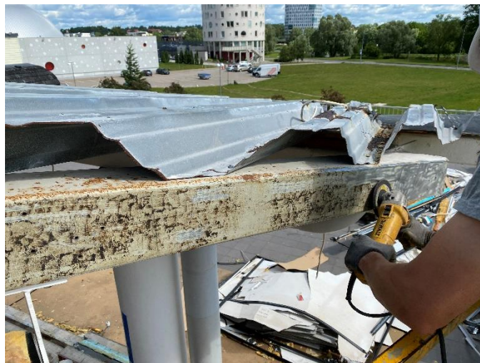
Joonis 3.17 Fermide lihvimine
