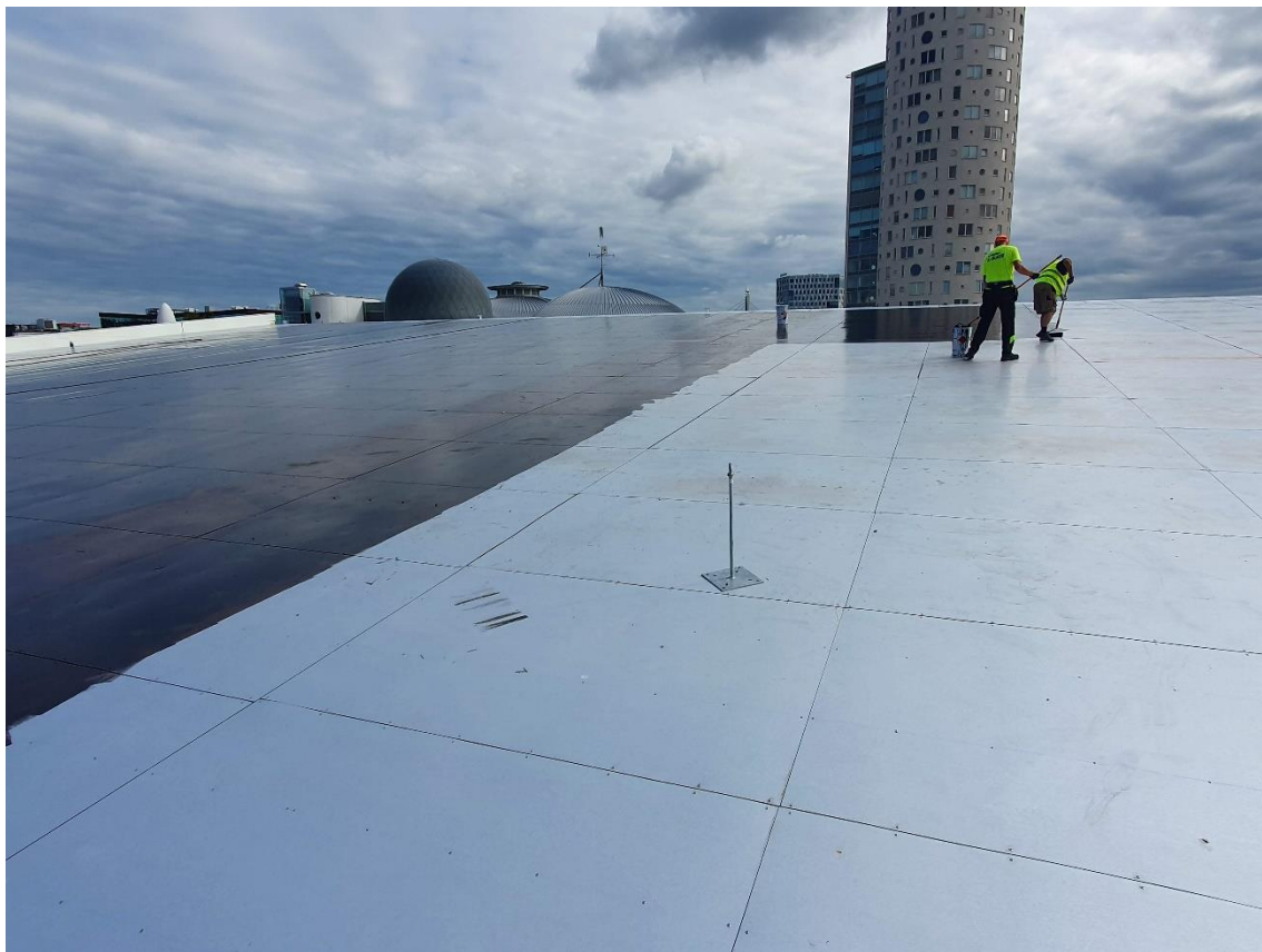
Joonis 3.20 Katuse kruntimine
