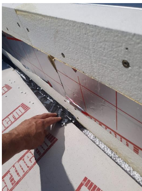
Joonis 3.29 Otsaseina soojustuse ja parapeti vahe
