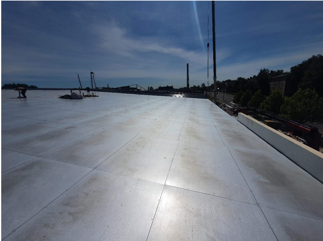
Joonis 3.19 Silepleki paigaldus
