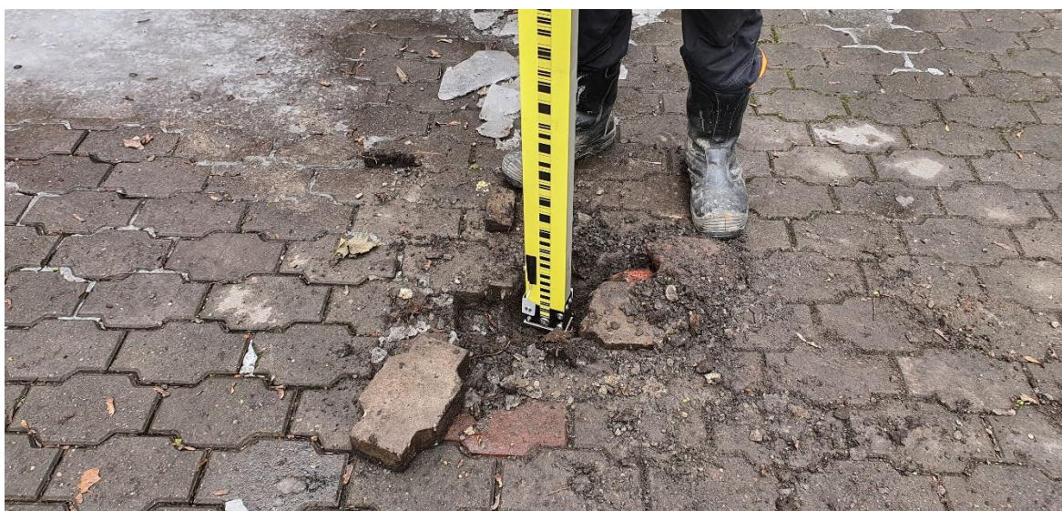
Joonis 6.8 Hotell Viru vajumiste lähtereeper Rp7, mis asub kaitsekatteta sillutuskivide all.
