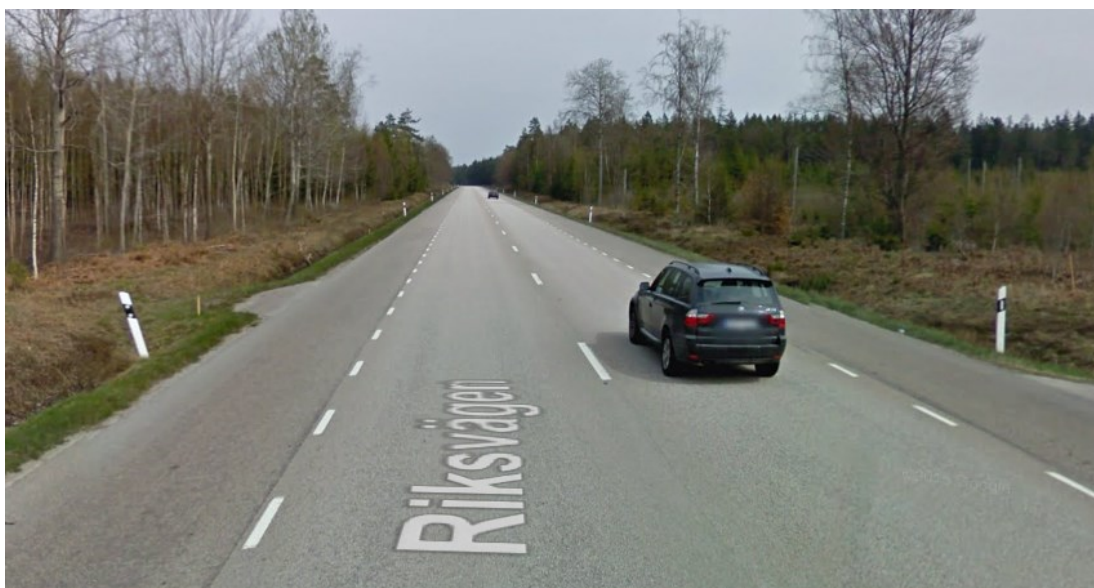
Joonis 2.2: 13,0 m laiune kahe rajaline maantee.
