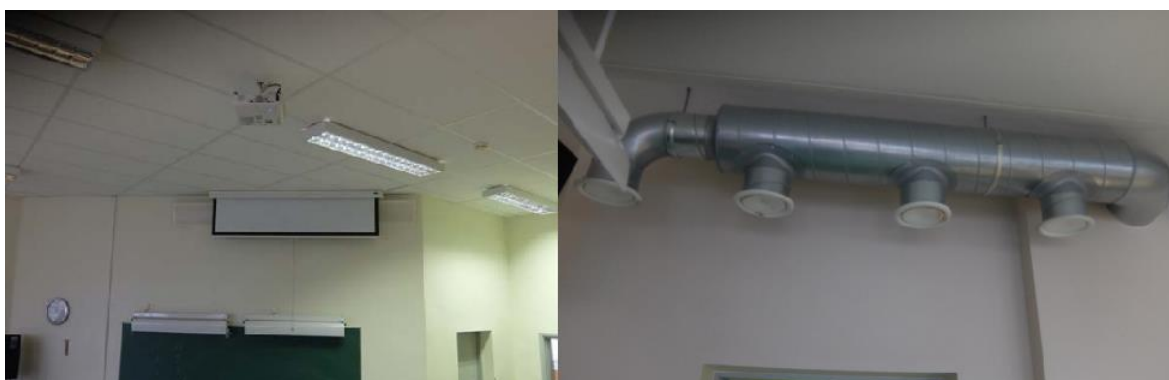
Joonis 5.5 Vasakul sissepuhkerestid kaetud projektori ekraaniga, paremal sissepuhkeplafoonid suletud ja kaetud teibiga [10]
