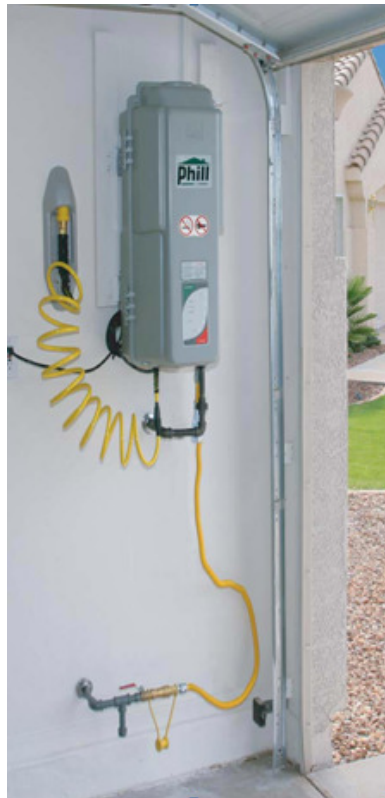
Joonis 2.3 PHILL CNG kodus tankimise seade [34]
