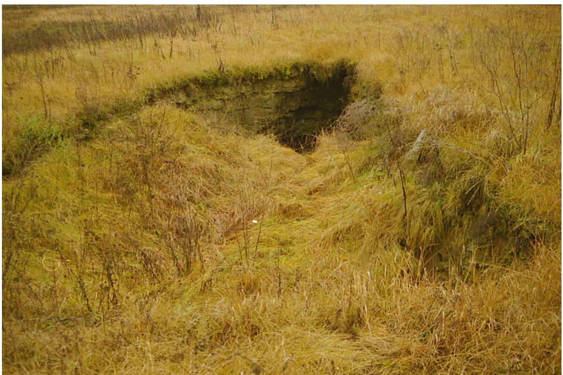
Joonis_2.33 Sillamäe uraanikaevanduse käigu lahtine varing E. Niitlaane foto; 2003; X 6591845; Y 711337
