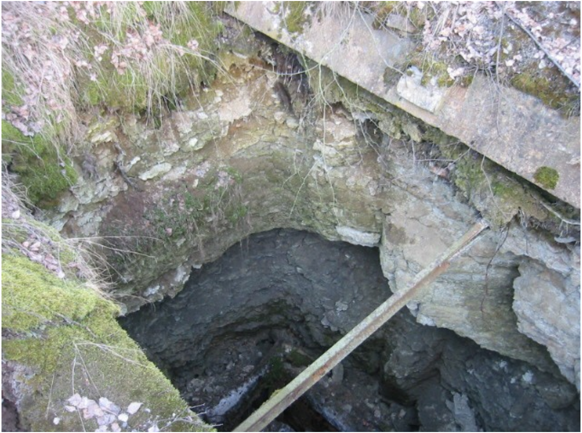
Joonis_2.30 Sillamäe uraanikaevanduse peatuulutusšahti nr 1 lahtine varing.
