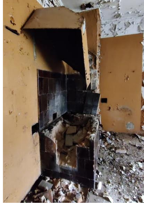
Joonis 2.26 Lagunenud soemüür ja pliit (Foto: autor, aprill 2021)
