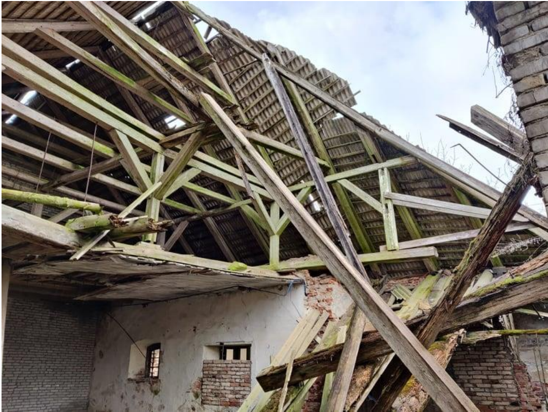
Joonis 2.15 Sissevarisenud katuse- ja vahelaekonstruktsioon hoone põhjaosas (Foto: autor, november 2020)
