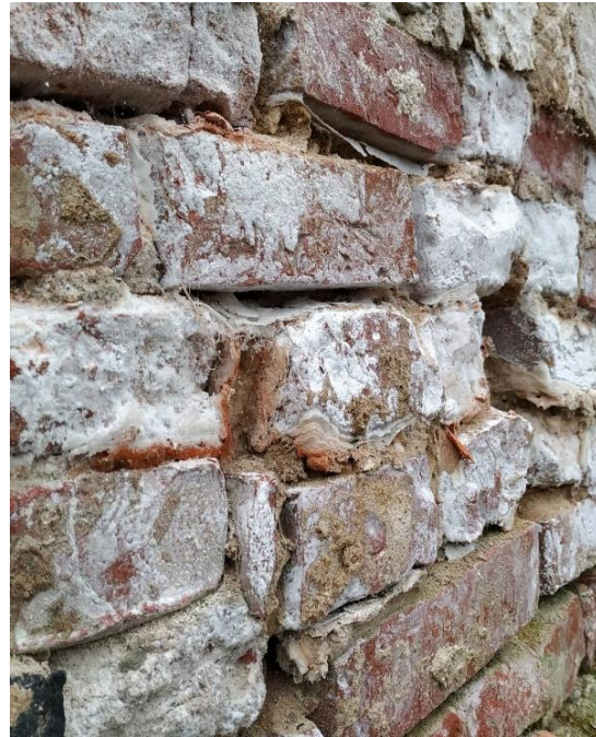
Joonis 2.7 Soolad välisseinte põletatud savitellistel (Foto: autor, aprill 2021)
