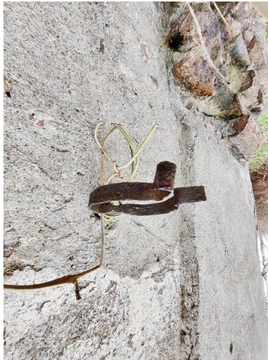
Joonis 2.29 Säilinud vihmaveetoru kinnitus (Foto: autor, aprill 2021)
