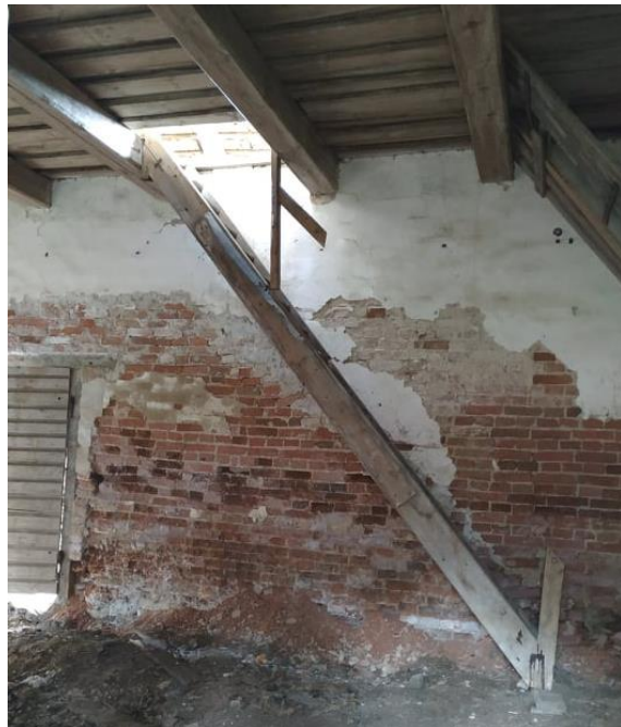
Joonis 2.28 Pööningule viiv puittrepp (Foto: autor, november 2020)
