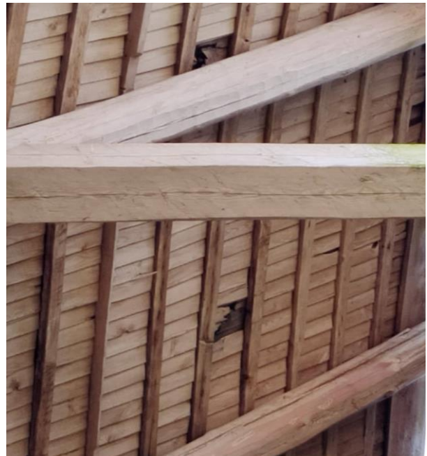
Joonis 2.17 Kohati säilinud algupärane sindelkatus (Foto: autor, aprill 2021)
