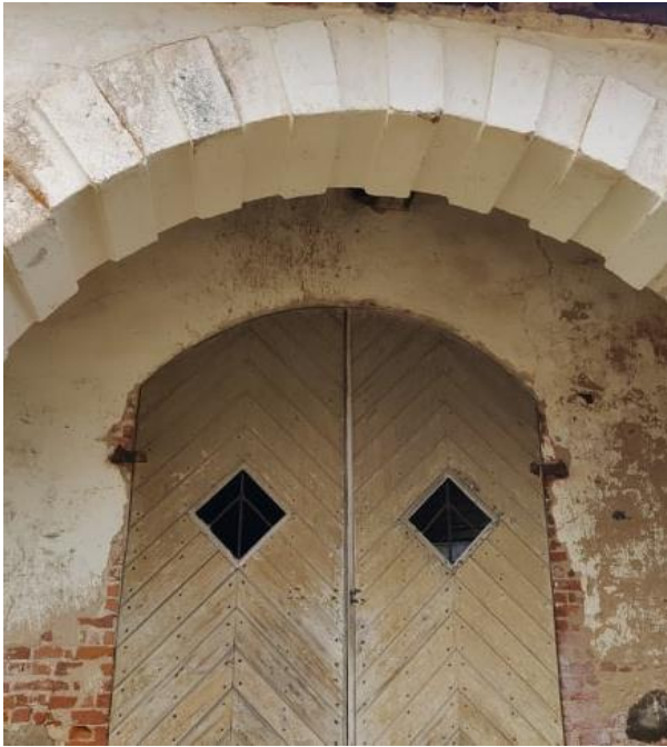
Joonis 2.22 Diagonaallaudisega ja rombakendega välisuks (Foto: autor, november 2020)
