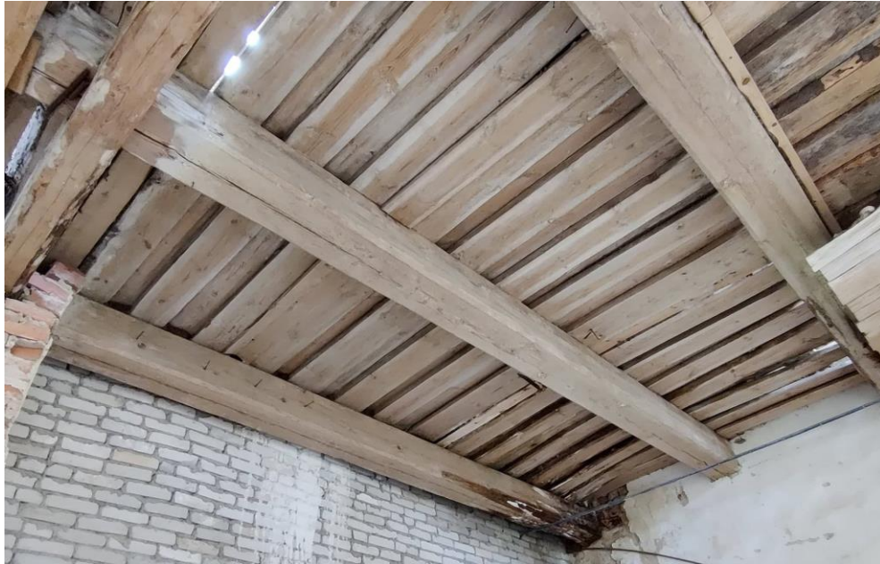
Joonis 2.14 Vaade laetaladele ja laudisele (Foto: autor, aprill 2021)
