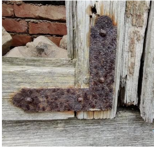
Joonis 2.24 Säilinud akna sepsidetail (Foto: autor, november 2020)
