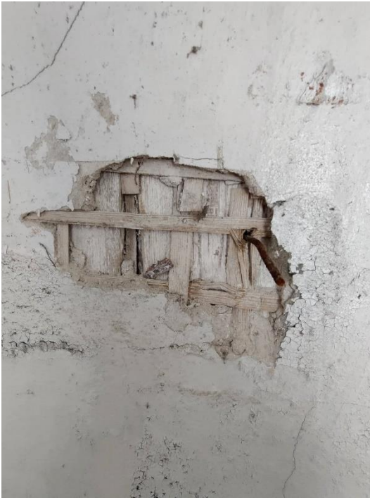
Joonis 2.11 Krohviga kaetud sisesein (Foto: autor, aprill 2021)
