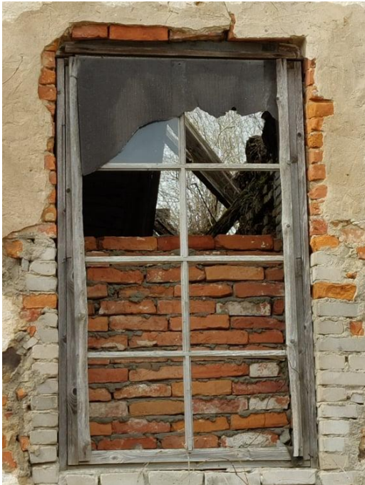
Joonis 2.20 Vaade kinnilaotud aknale (Foto: autor, november 2020)
