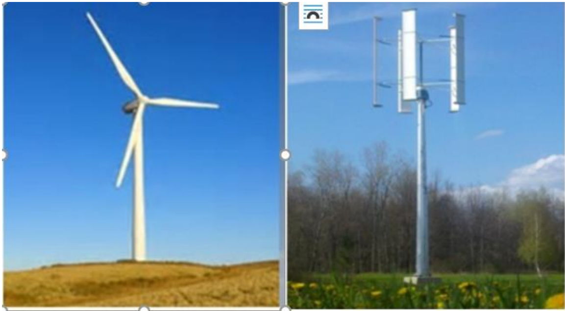
Joonis 4 Rõhtteljega (horisontaal) ja püstteljega (vertikaal) tuulegeneraator (Windpower, 2017)
