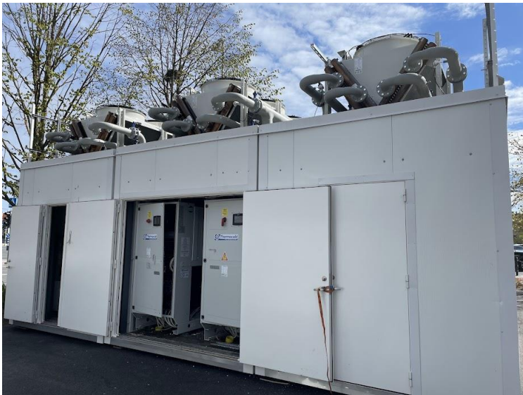
Joonis 5.3 Ahtri konteinerjaama vaatepilt väljast
