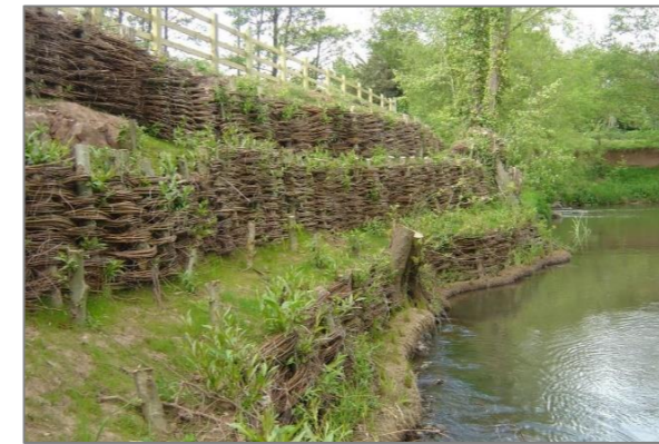
Joonis 3.5 Skeem Kalda kindlustamine pajuokstest punutud tugiseina abil: rajatud tugisein (vasakul) ja skeem (paremal).
