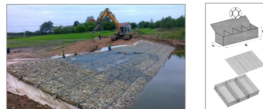
Joonis 3.8 Gabioontarind kaldakindlustamisel: rajamine (vasakul) ja korvi näide (paremal) Allikas: Hydroseal OÜ veebilehekül
