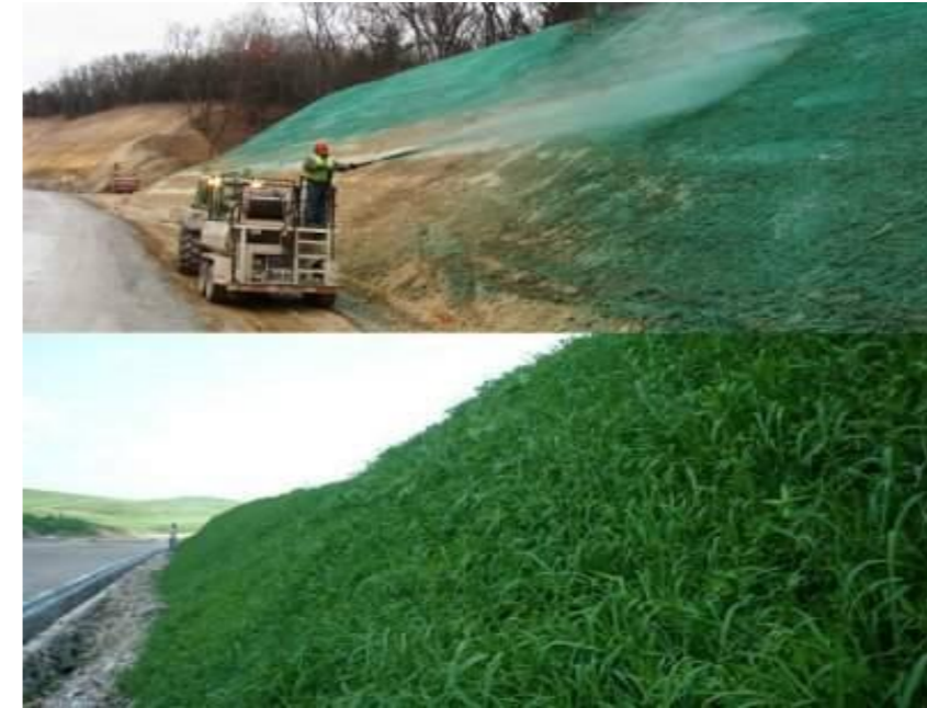
Joonis 3.1 Hüdrokülvi tegemine (üleval) ja eeldatav tulemus (all)
