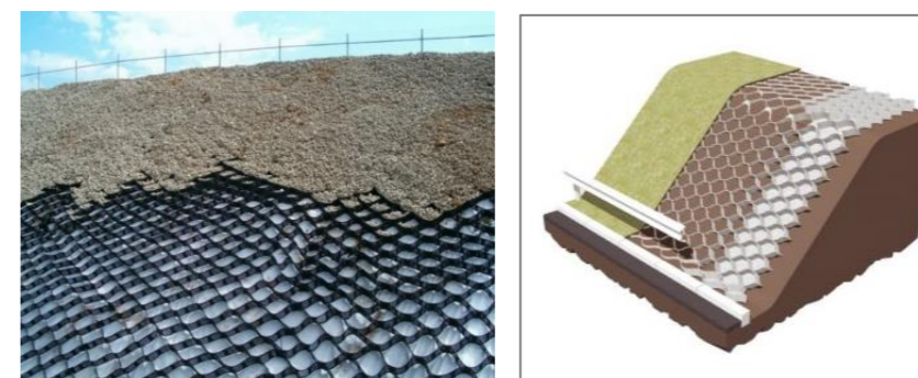
Joonis 3.15 Näide 3D geokärjete kasutamisest kalda kindlustamisel. 3D kärje paigaldamine elus (vasakul) ja skemaatiline konstruktsioon 3D kärjega (paremal)
