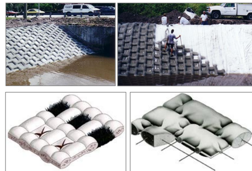
Joonis 3.8 Kangaraketise abil valminud betoonist kaldakindlustis: valmis kallas (üleval vasakul), kangasraketise paigaldamise ja betooniseguga täitmise protsess (ülral paremal), betooniseguga täispumbatud kangasraketiste 3D lõiged (all vasakul ja paremal)
