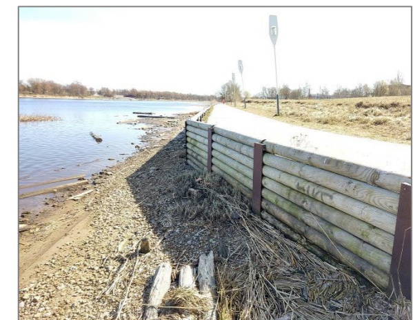
Joonis 3.6 Kaldakindlustamine kasutades palke. Püstpalkidest kaldakindlustise skeem (vasakul), serviti paigaldatud palkidest kaldakindlustis Pärnu jõe vasakul kaldal(paremal)
