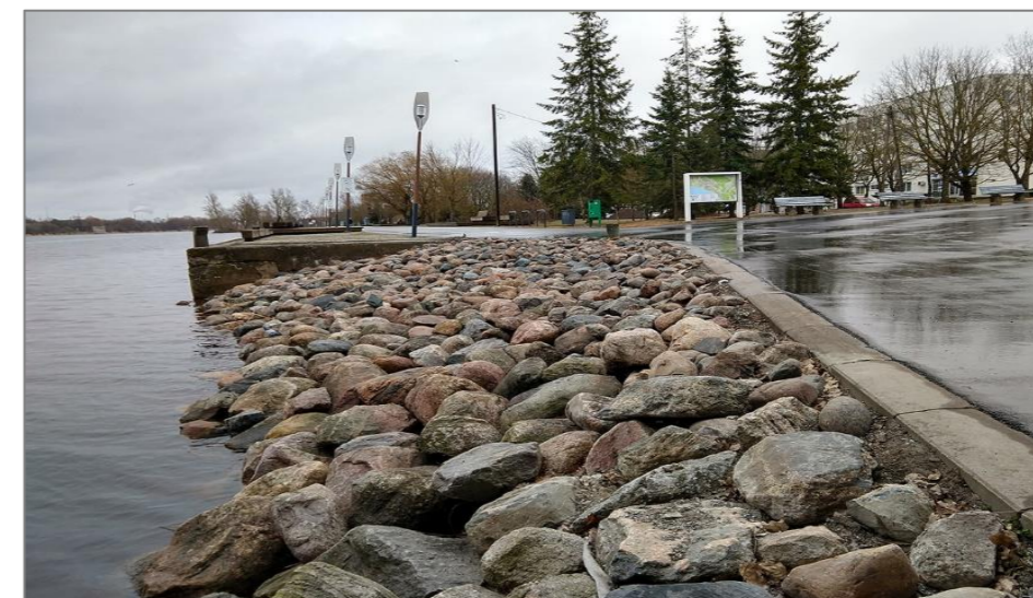
Joonis 3.7 Kivipuistega kaldakindlustise näide. Pärnu jõe vasakkalda tervisespordirada Allikas: Autori tehtud foto
