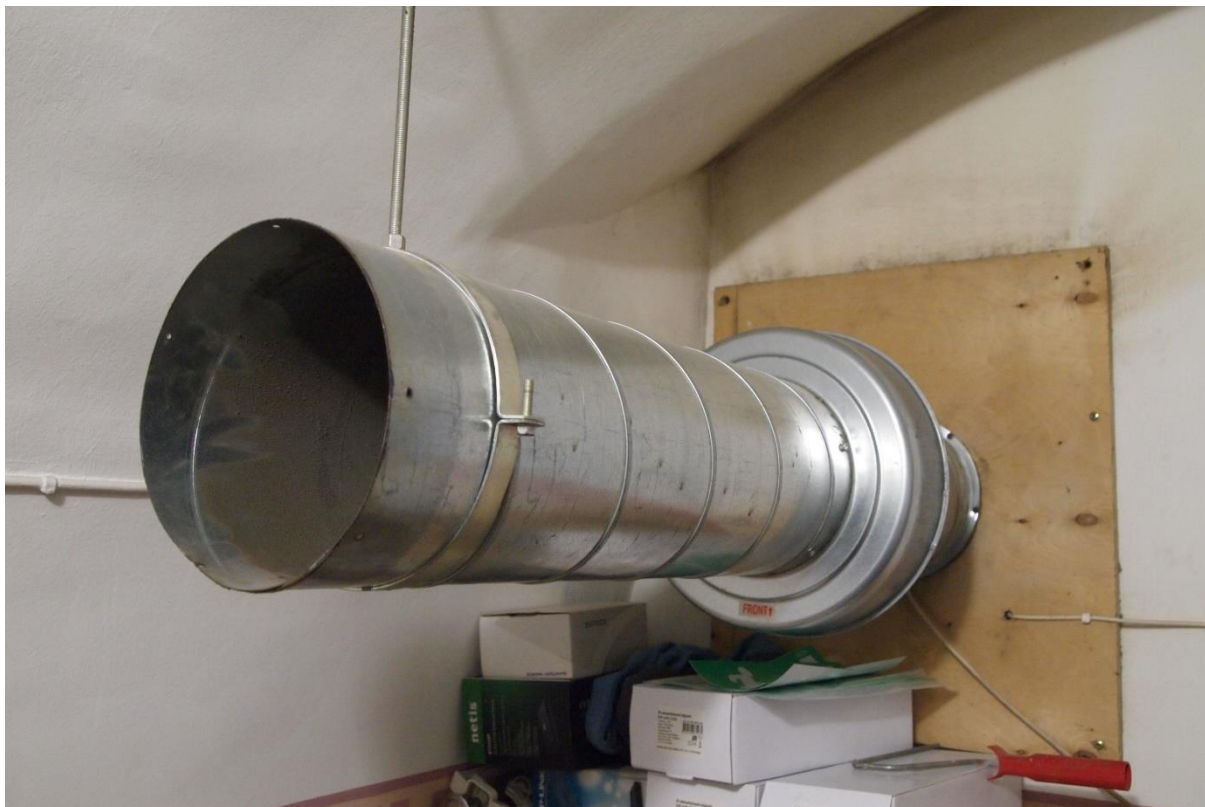
Joonis 5. Keldris asuv väljatõmbeventilaator hoone lääneosas
