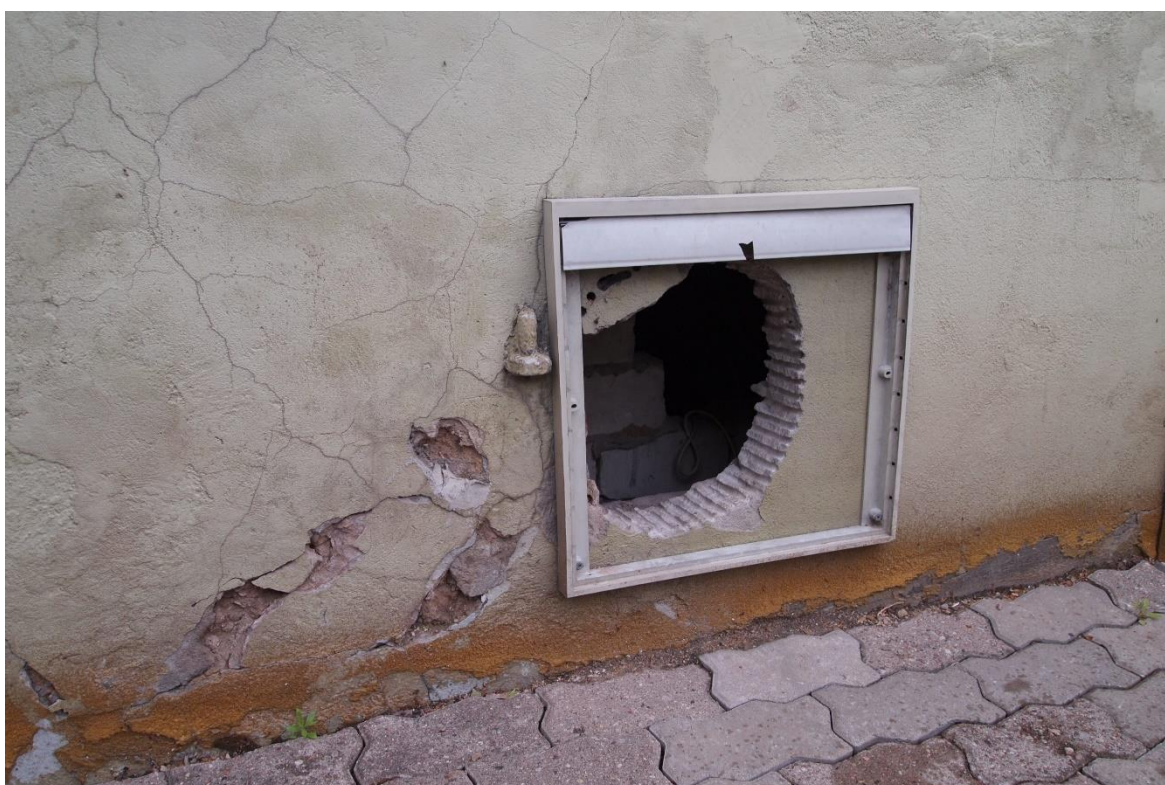
Joonis 6. Olemasoleva ventilatsiooni väljatõmbesüsteemi läbiviik välisseinast lääneküljelt
