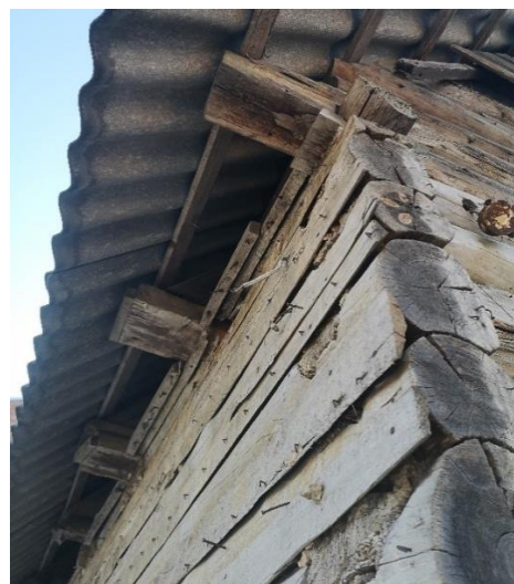
Joonis 3.14 Vahelaetalade otsad (autori foto, märts 2022)
