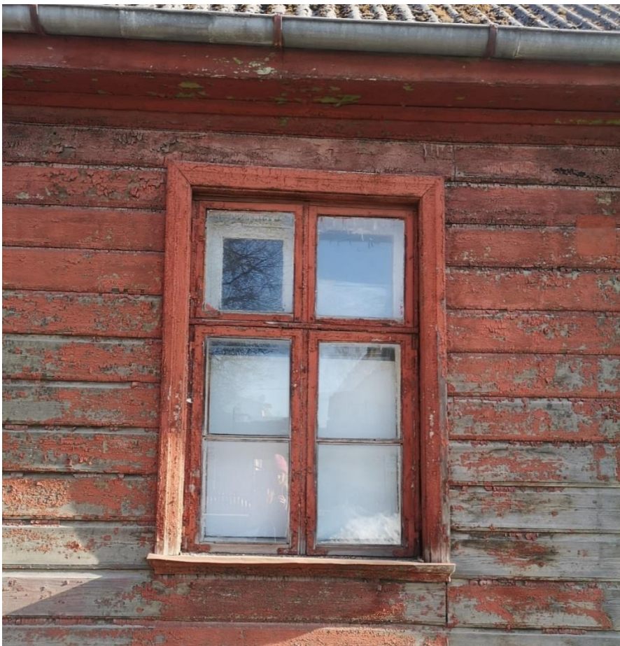
Joonis 3.19 Tänavapoolsel fassaadil algupärane aken (autori foto, märts 2022)
