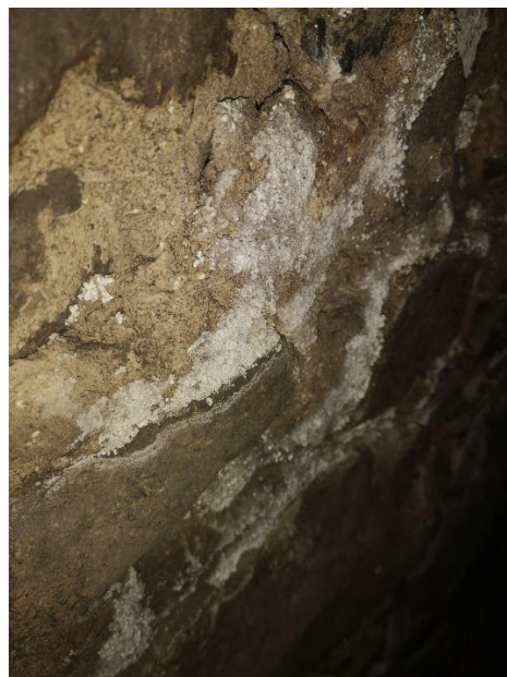
Joonis 3.2 Maakivimüüritise sisemisel pinnal nähtav soolade kiht (autori foto, märts 2022)
