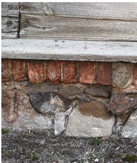
Joonis 3.1 Tänavapoolne sokkel koos veelauaga (autori foto, märts 2022)
