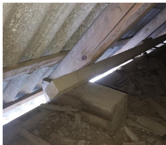
Joonis 3.18 Ära lõigatud laetala ühendustapp sarikaga (autori foto, märts 2022)
