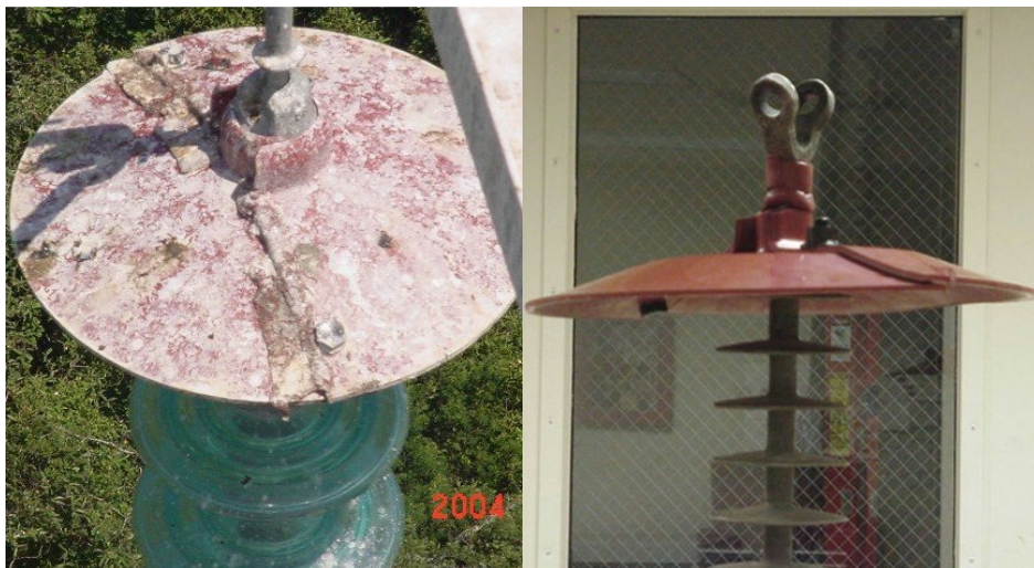
Joonis 6.3 Spetsiaalne kate vähendamaks isolaatori saastumist linnuväljaheidete poolt [44]
