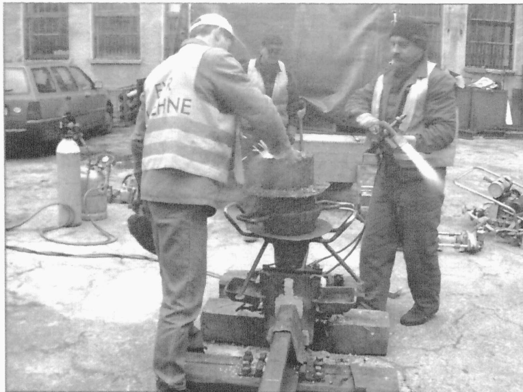
TERAS SULAB SILMNÄHTAVALT: Termitkeevitus on vaatamänguline, sest relsiootste ühendamine toimub lõõskavas kuumuses mõne hetkega.
