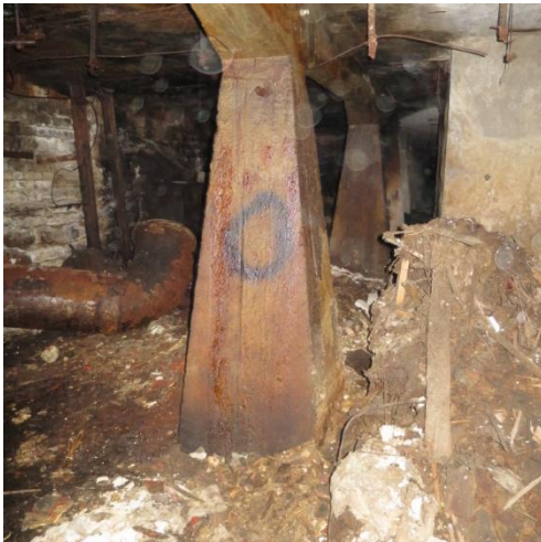
Foto 22. Kolmanda seisunditaseme postvundament (post nr. 136)
