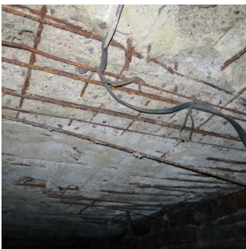
Foto 26. Teise seisundi vahelae piirkond
