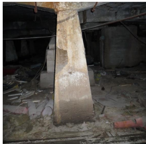
Foto 21. Teise seisunditaseme postvundament (post nr. 182)
