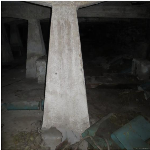
Foto 18. Esimese seisunditaseme postvundament (post nr. 10)
