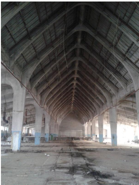
Foto 2. Lutheri masinasaali esimese korruse vaade
