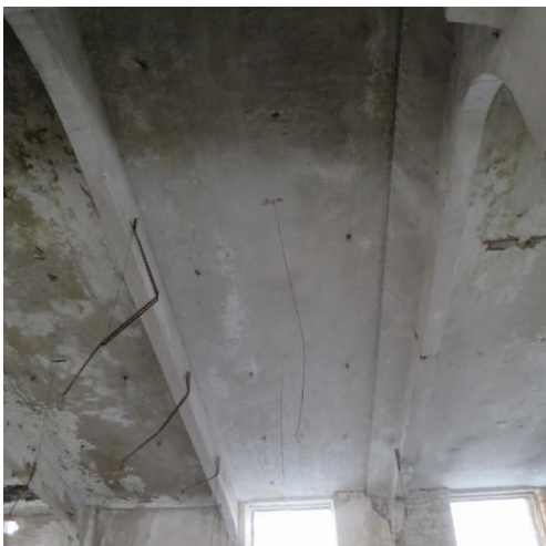
Foto 36. Esimese seisunditaseme laeplaat PL36
