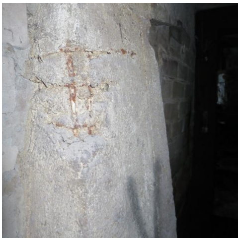
Foto 20. Teise seisunditaseme postvundament (post nr. 1)
