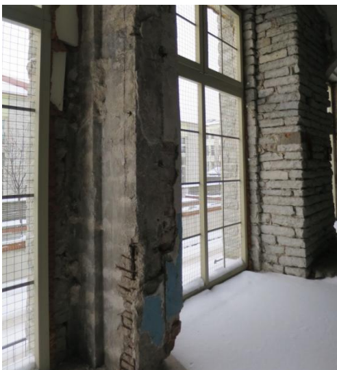
Foto 32. Osaliselt teise seisukorra post RP25
