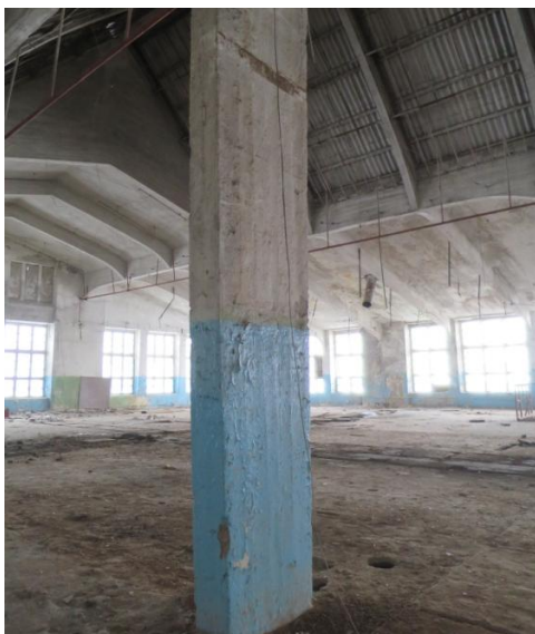
Foto 30. Esimese seisunditaseme pearaami post
