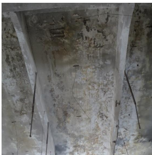
Foto 39. Valdavalt teise seisunditaseme laeplaat PL21
