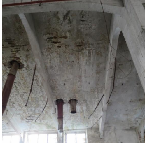
Foto 41. Osaliselt kolmanda seisunditaseme laeplaat PL24
