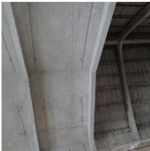
Foto 37. Esimese seisunditaseme laeplaat PL51
