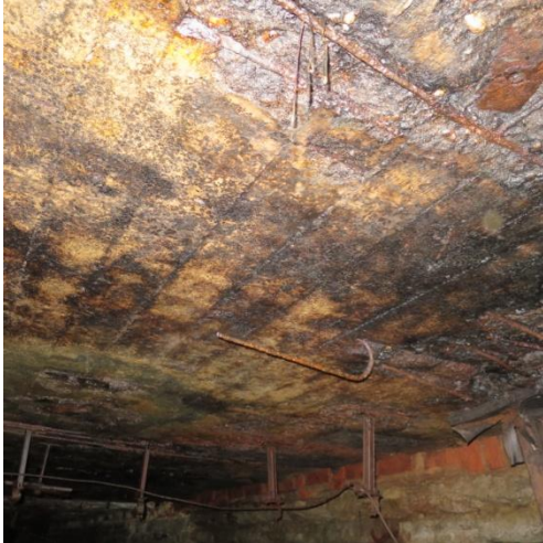
Foto 28. Kolmanda seisundi vahelaes piirkond - tugev õlikahjustus
