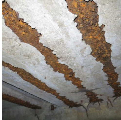
Foto 29. Kolmanda seisundi vahelaes piirkond - ümberehitatud korrodeerunud terastaladel
