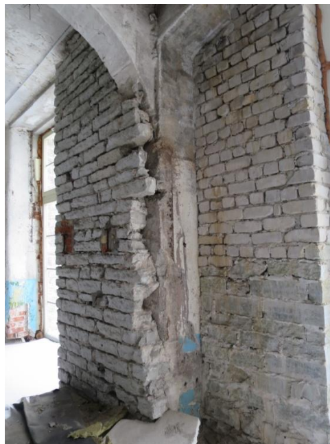
Foto 31. Esimese seisunditaseme pearaami post
