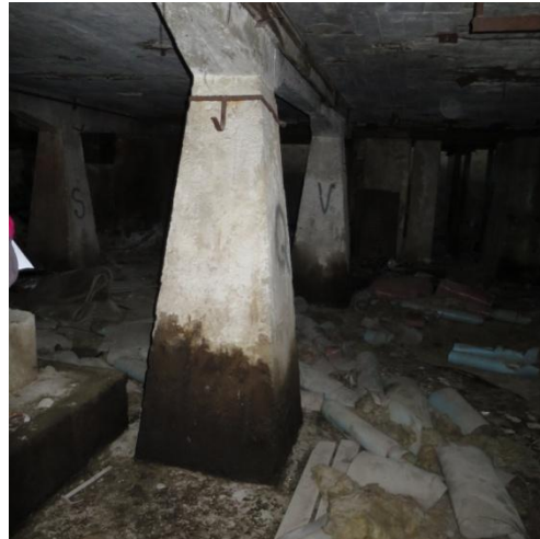
Foto 23. Kolmanda seisunditaseme postvundament (post nr. 177)
