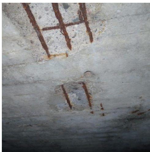
Foto 27. Teise seisunditaseme vahelae piirkond
