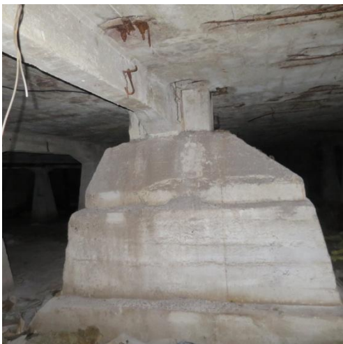
Foto 12. Esimese seisunditaseme vundament
