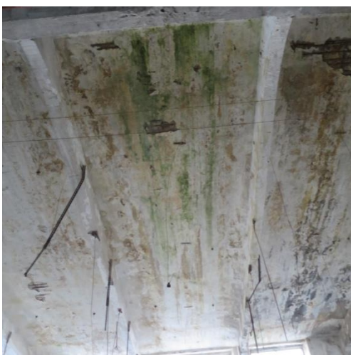
Foto 38. Valdavalt teise seisunditaseme laeplaat - vohav vetikas PL27
