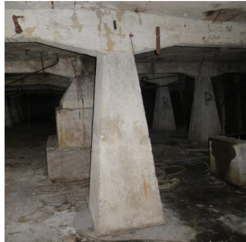
Foto 19. Esimese seisunditaseme postvundament (post nr. 83)
