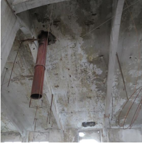
Foto 40. Osaliselt kolmanda seisunditaseme laeplaat PL32
