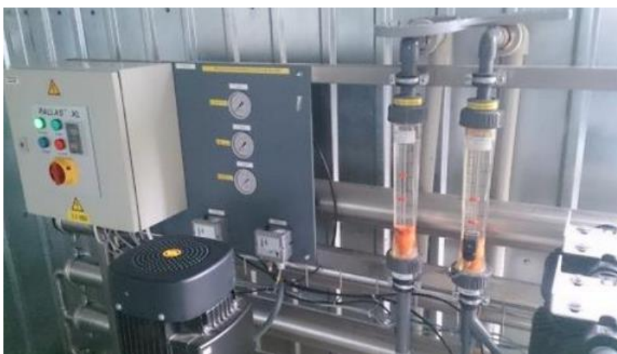
Joonis 2.5 Vahenurme veetötlusjaama pöördosmoosiseade (Põhja-Pärnumaa arendamise kava, 2020)
