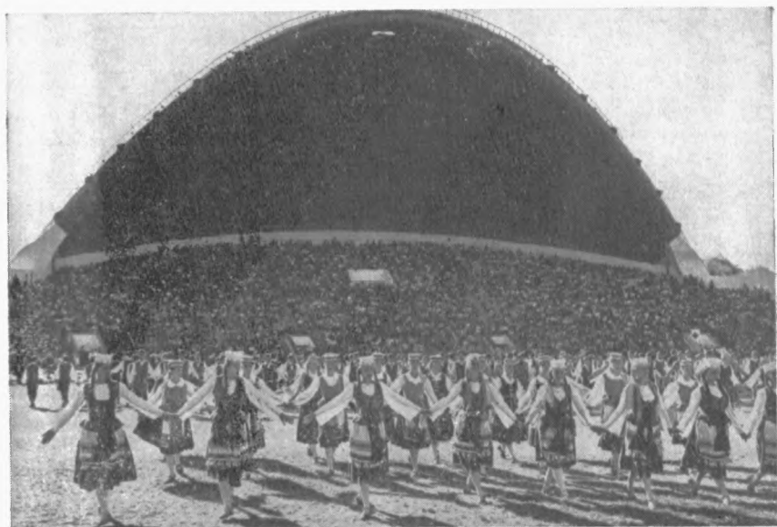
DFK-liimpuidust valmistatud kandetaladega sild TPI õppejõudude osavõtul projekteeritud ja ehitatud Tallinna laululava
