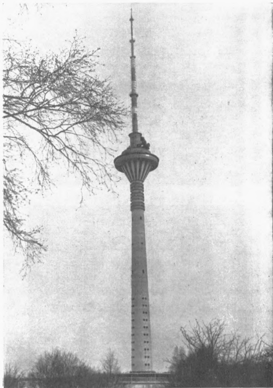
Instituudi teadlaste loodud uudest ehitusmaterjalist valmistatud Tallinna teletorn
