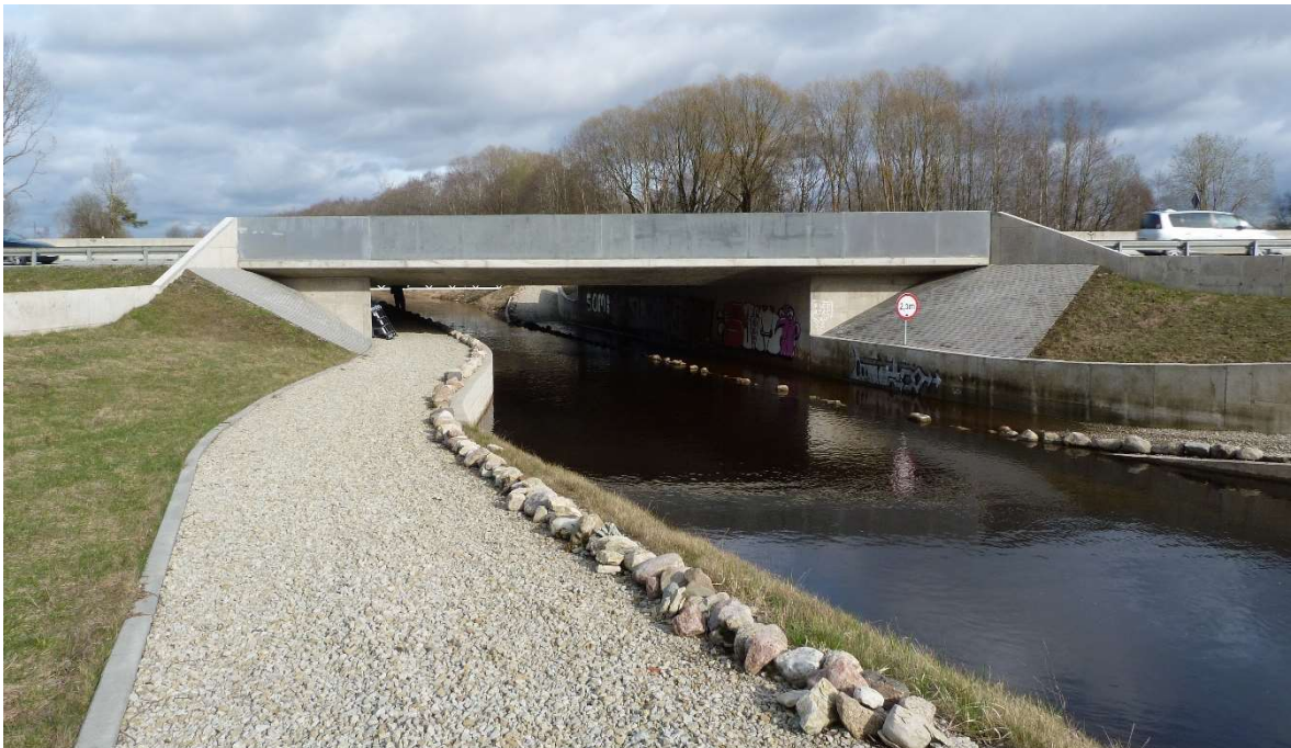
Foto nr. 7. Vaade Rae kanali sillale.
