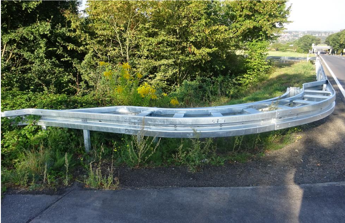
Joonis 3.15 Ristmiku raadiusel kasutatav energianeelduvusega terminal Arcus Primus 90
