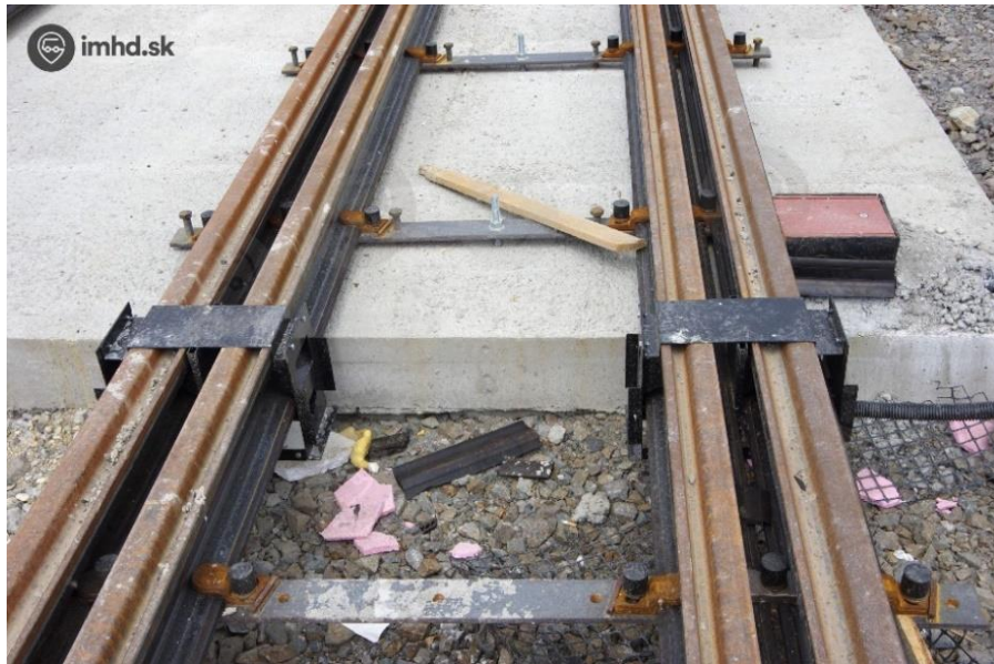
Joonis 4.18 Latt-terasliiper kahe rööpmega [43]
