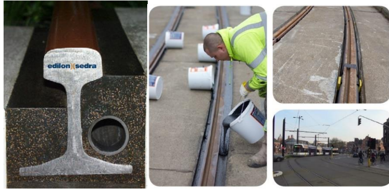
Joonis 5.3 Pideva toetusega elastselt sängitatud rööbas edilon)(sedra ERS-LS [48]
