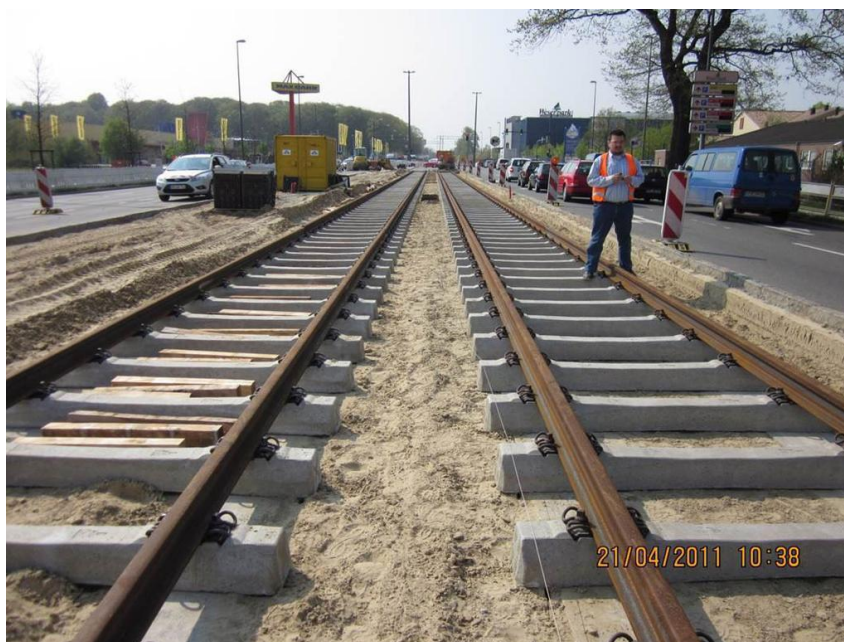
Joonis 6.5 Bremeni trammitee konstruktsioon [Erakogu]
