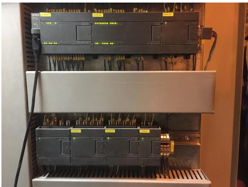
Рисунок 7. Контроллер и модули расширения (фото автора)
