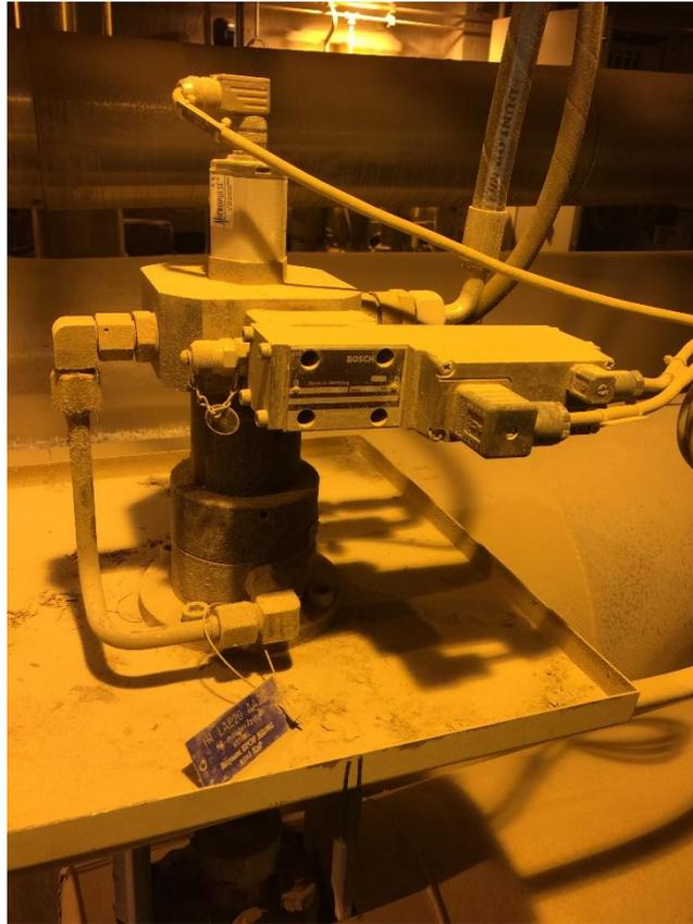
Рисунок 2. Регулирующий температуру пара клапан (фото автора)
