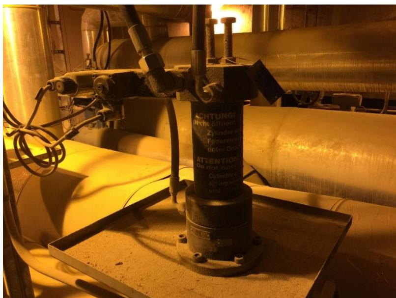
Рисунок 4. Запорный клапан впрыска питательной воды (фото автора)
