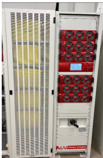
Joonis 2.2 UPS. Vasakul akud, paremal - kontrolleri
