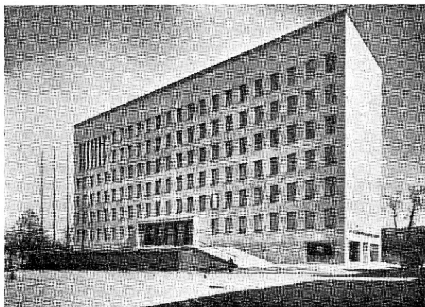
Joon. 4: Kotka raekojaohone, püstitatud konstruktiivses stiilis.
