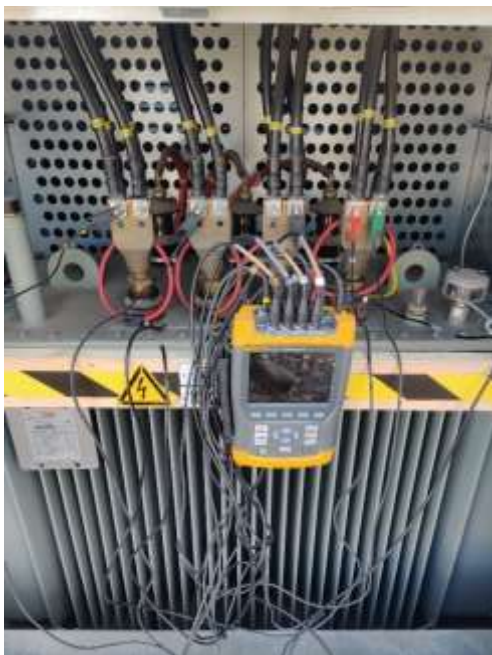
Joonis 3.2. Mõõdetud otse sisendtrafolt seadmega Fluke435
