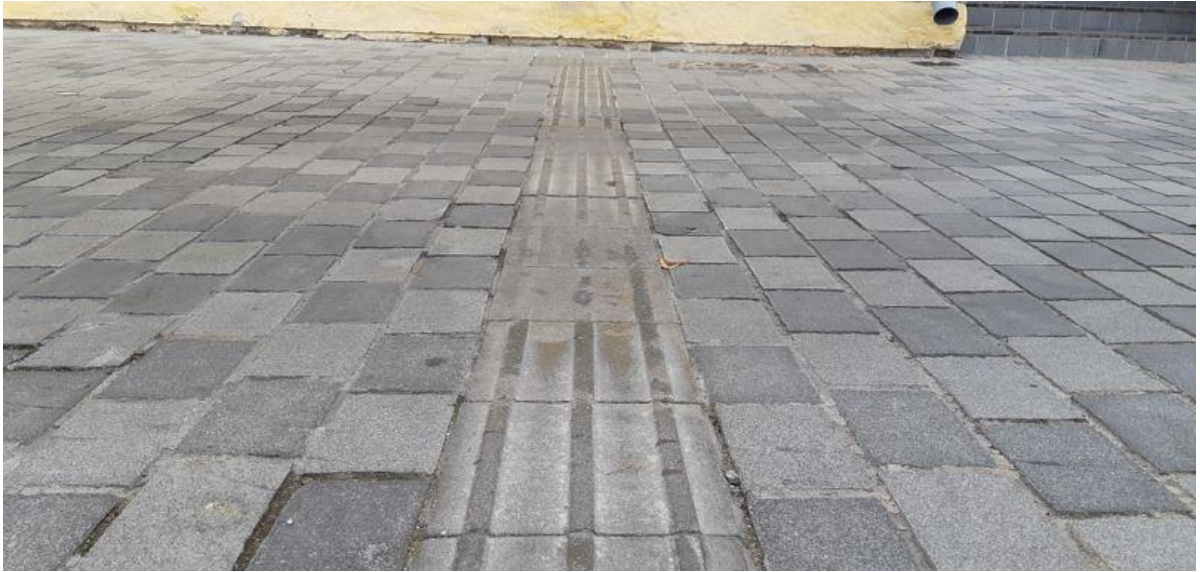
Joonis 3.5 Pilt Riho Eichfuss, Kuressaare keskväljak taktiilsete kivide kulumine sõidukoormuse all [2]
