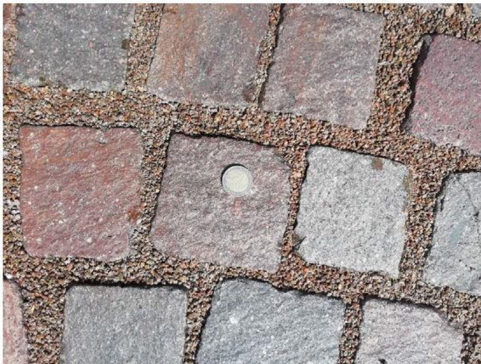
Joonis 3.7 Näide liiga suurest vuugivahest
