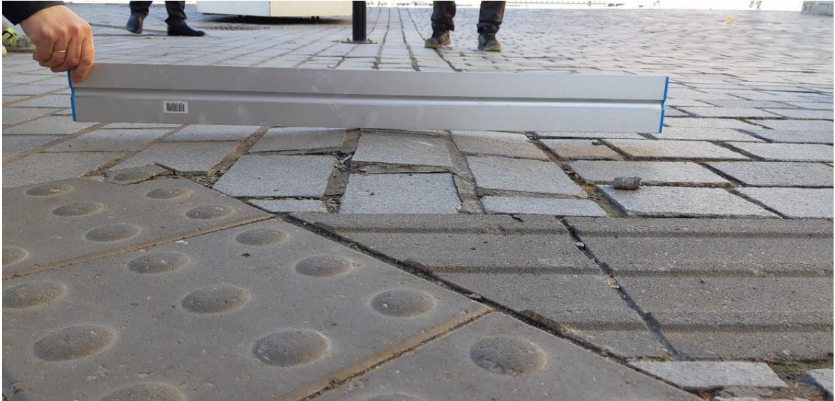
Joonis 2.1 Pilt Riho Eichfuss, Katte ebatasasus soojuspaisumisest tingitult Kuressaare keskväljakul [2]
