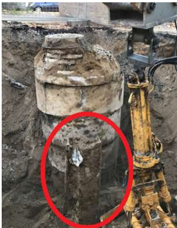
Joonis 1.23. Avastatud puurkeha taksitus (ehituse täitedokumentatsioon)
