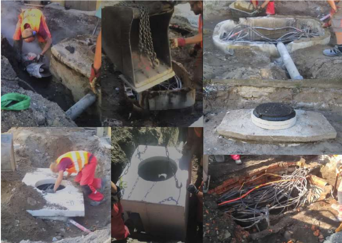
Joonis 1.1. Juurdeveo tn sidetööde teostamine (väljavõtted täitedokumentatsioonist)
