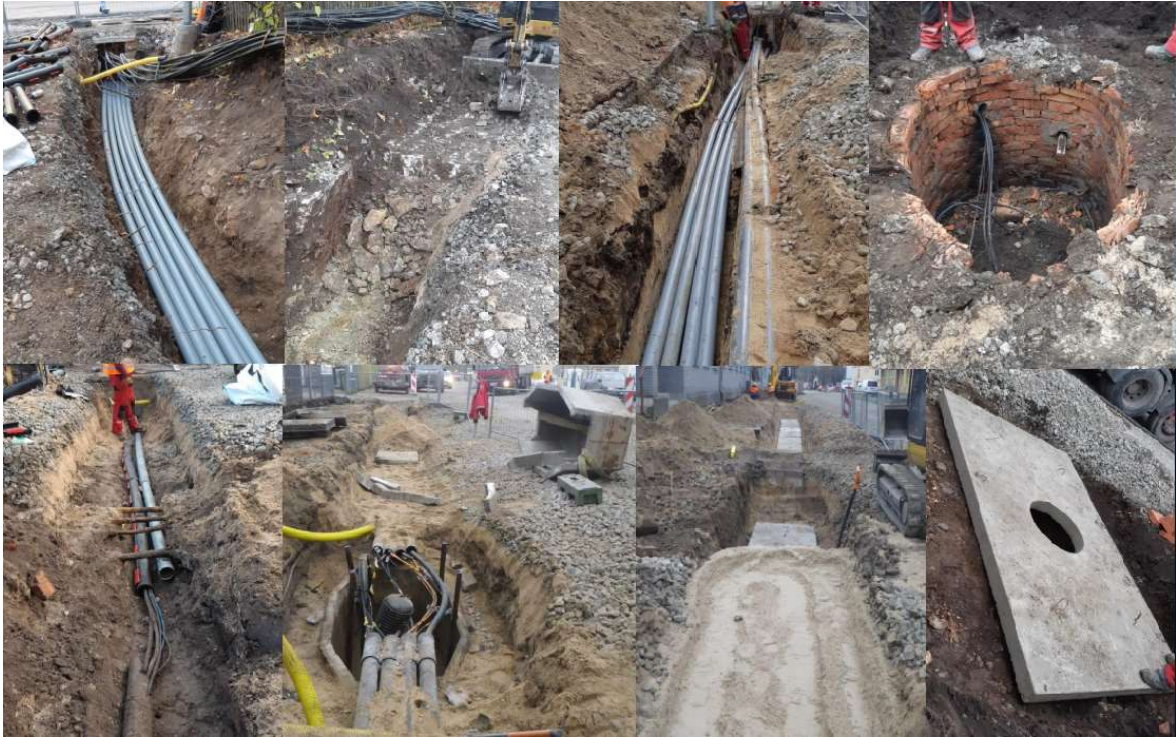
Joonis. 1.4 Sidekaablite ümberehitustööd Türi tänaval (väljavõtted projekti täitedokumentatsioonist)
