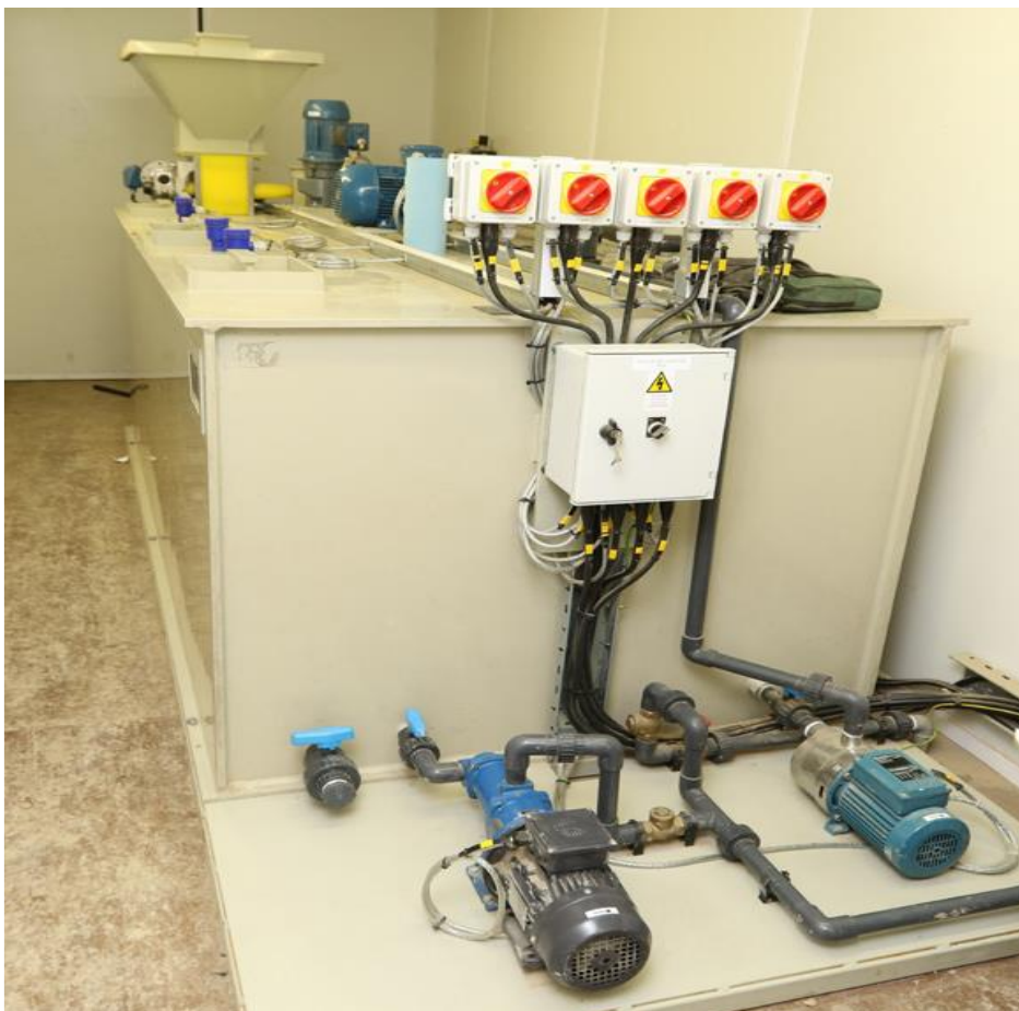
Joonis 4. Flokulandi segamis- ja doseerimisjaam. (CDE, 2025)
