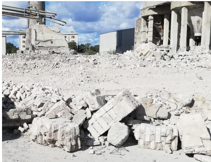
Joonis 2.2 Kunda tsemenditehase silo müüritise jäägid [autori erakogu]
