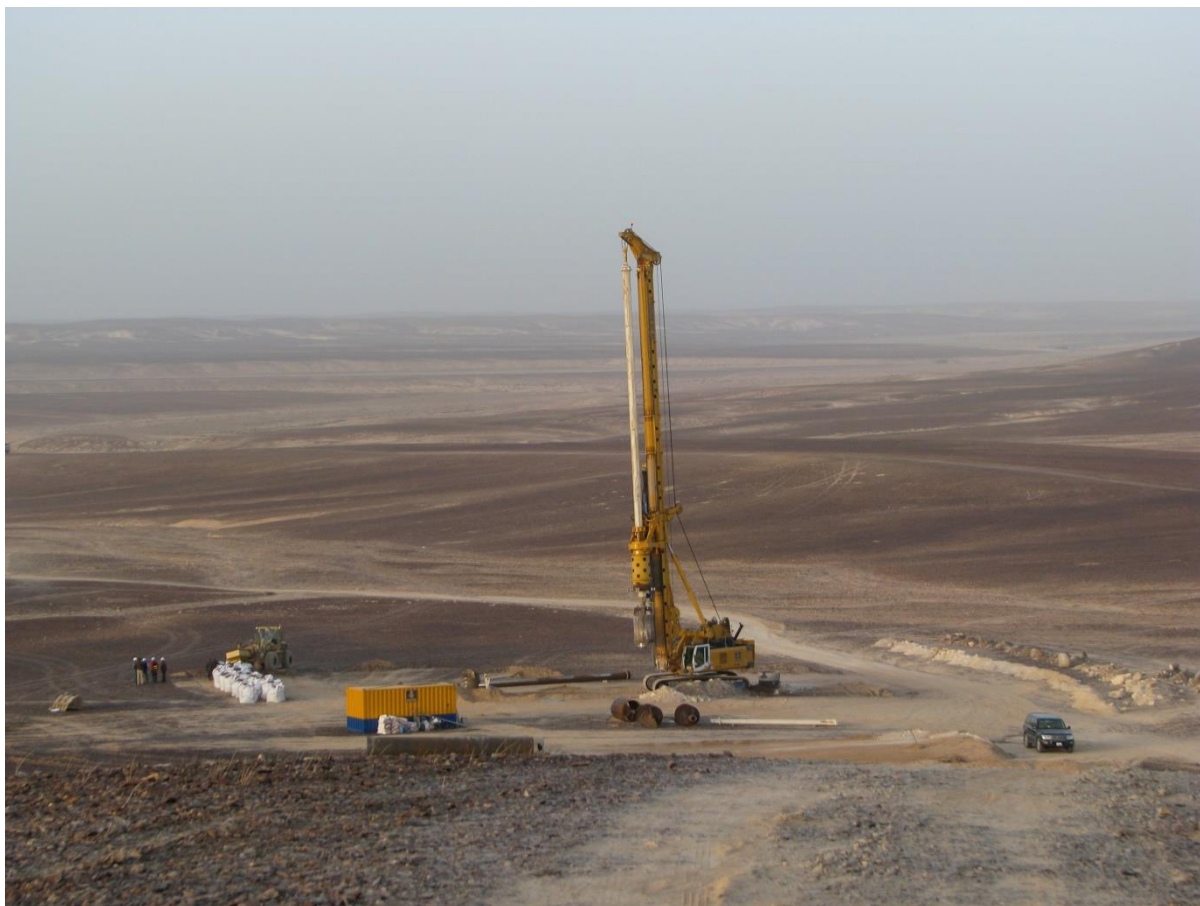
Pilt 2 Suure diameetriga puuraugu puurimine Jordaania (18)
