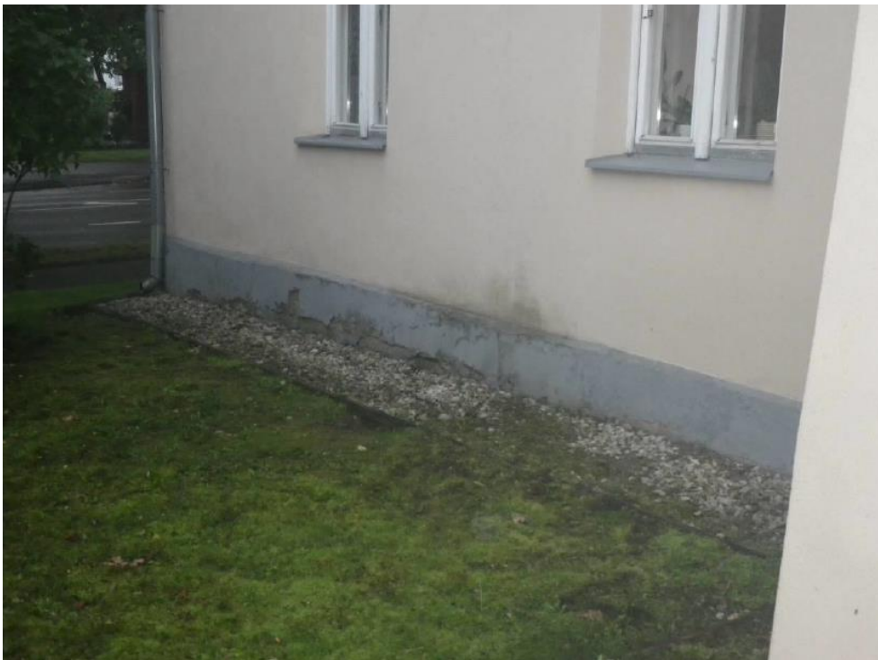
Joonis 22 Niiskus- ja külmakahjustusega sokkel. Autori erakogu
