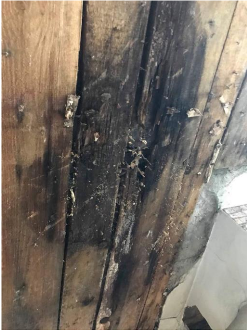
Joonis 19 katuse läbi sajamisest tingitud kahjustused. Autori erakogu
