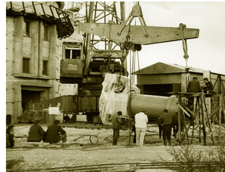
Joonis 23. Tõravere observatoorium. 1,5 m teleskoobi montaaž. http://to50.to.ee/suurte_ja_vaeikeste_teskoopi.htm
