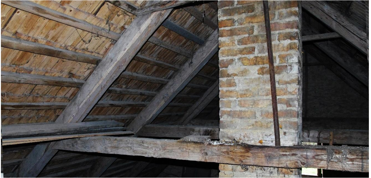
Joonis 40. Vaade hoone olemasolevatele katusekonstruktsioonidele
