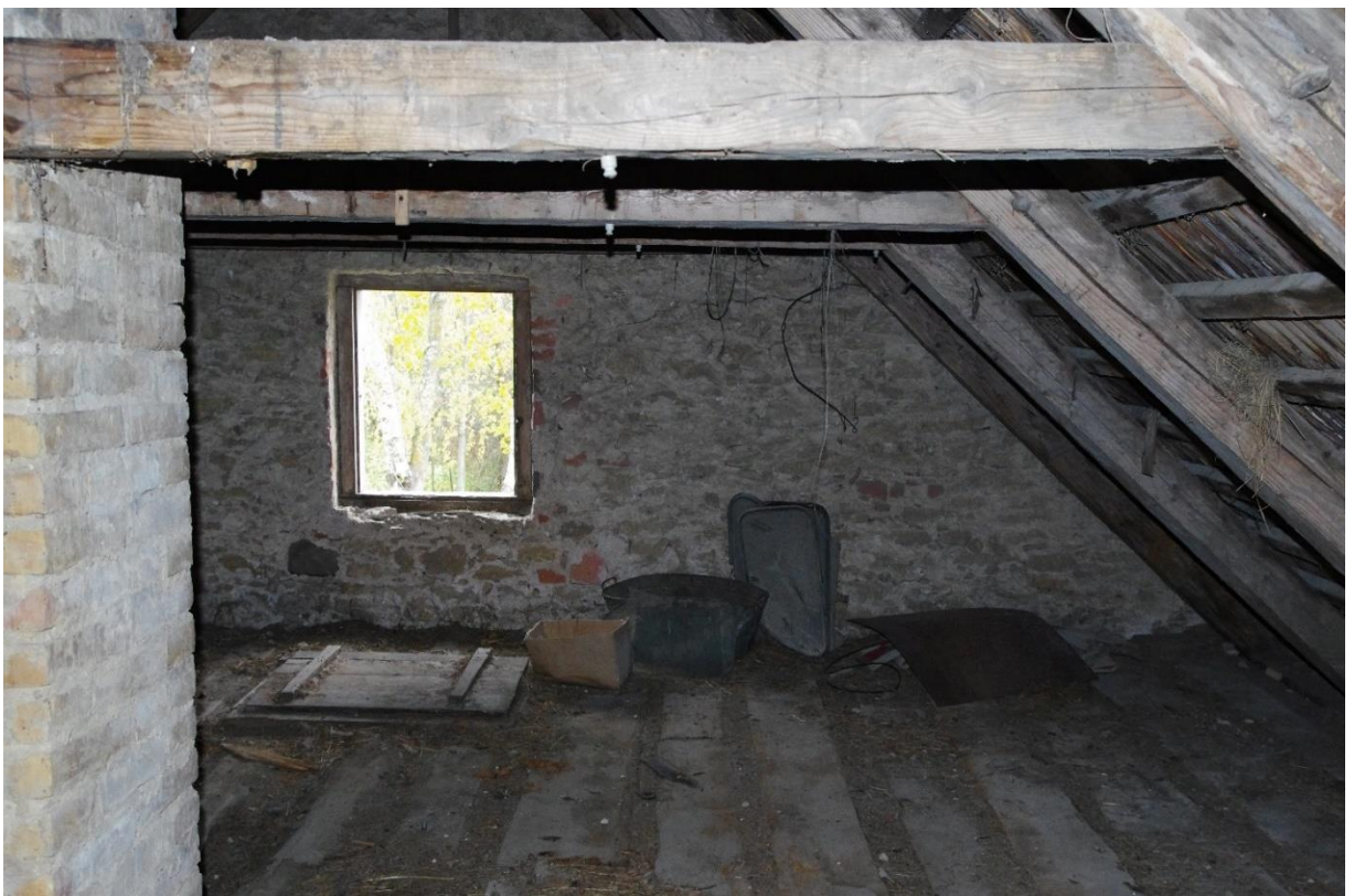
Joonis 41. Vaade hoone olemasolevale teisele korrusele
