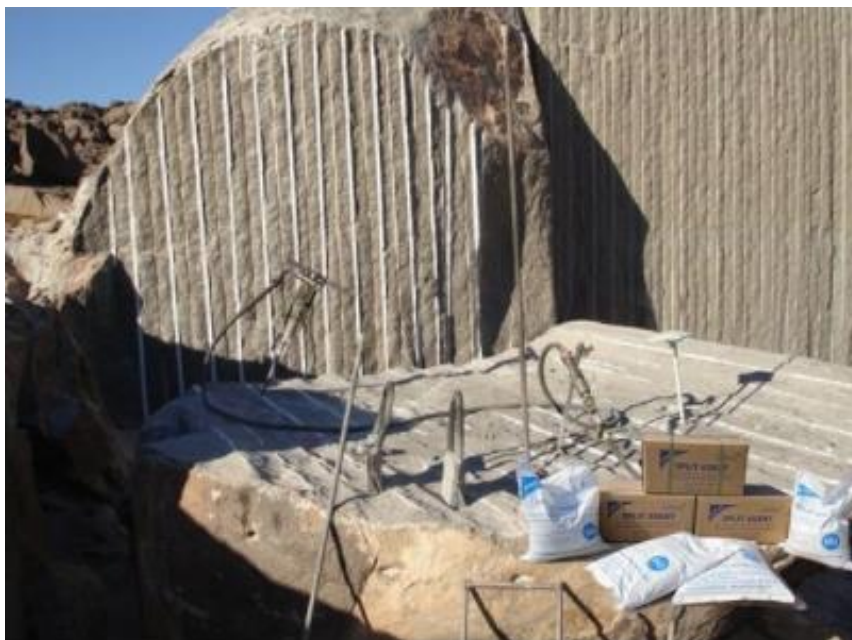
Joonis 17: Paisuvsegudega murtud kivim (Autor: Splitstar)
