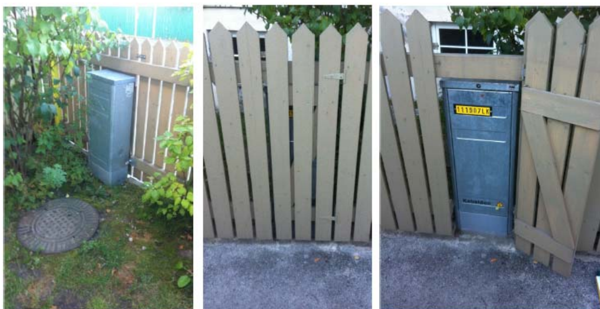
Joonis 5.7. Olemasolev Preesi tn 20 aeda siivistatud ja aiaväravaga kilbi lahendus
