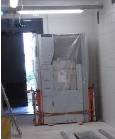
Foto 1.2 Jaotusseadme NXPlusC paneel transpordikärul
