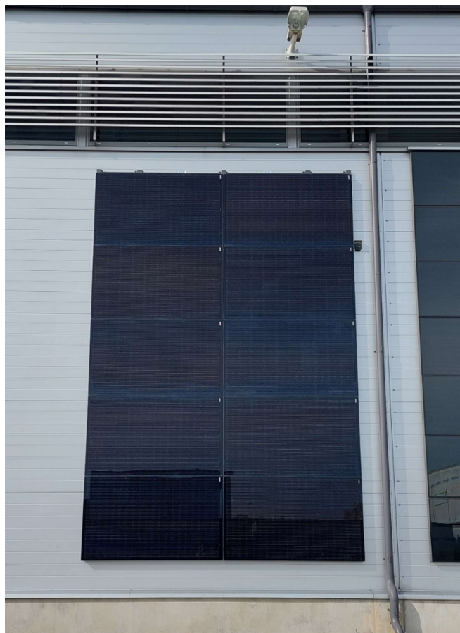
Sele 4.19 Päikesepaneelid seinal tootlikkuse mõõtmiseks
