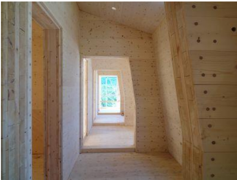
Joonis 1.2. Tüübeldatud ristkihtpuit [5]
