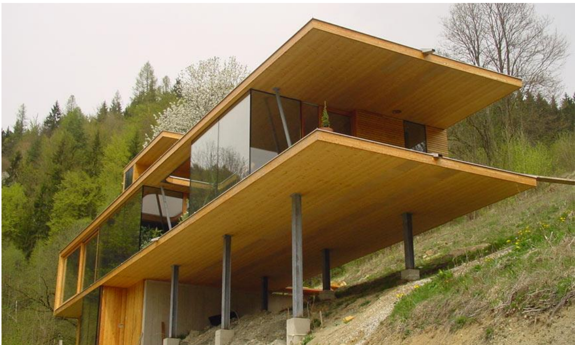
Joonis 1.7. Ristkihtpuidust paneelid toetatud postidele. Eramu Austrias [13]
