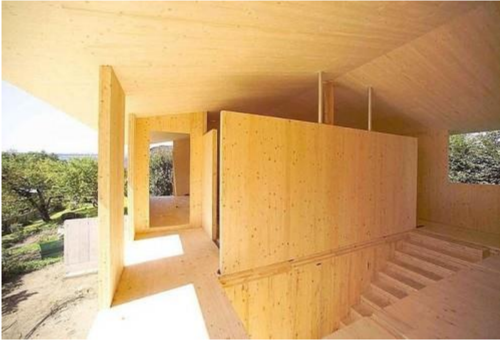
Joonis 1.4. Ristkihtpuidu kasutamine erinevate konstruktsioonelementidena [10]
