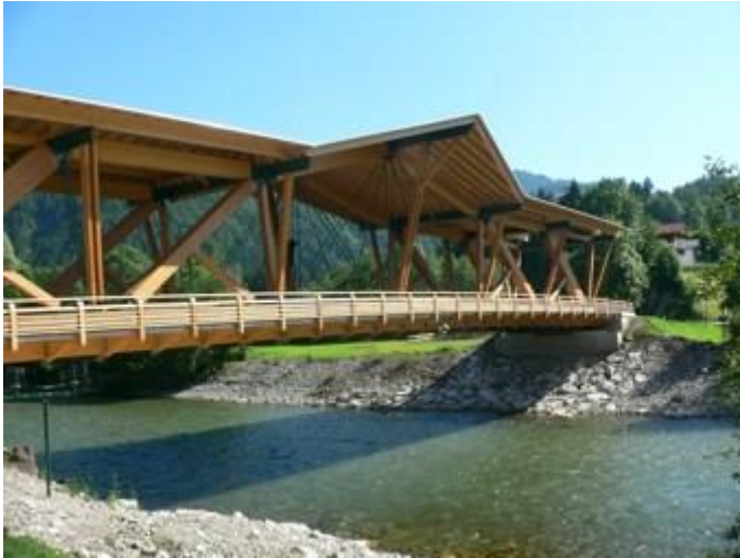
Joonis 1.6. Ristkihtpuidust sild Kössenis [12]
