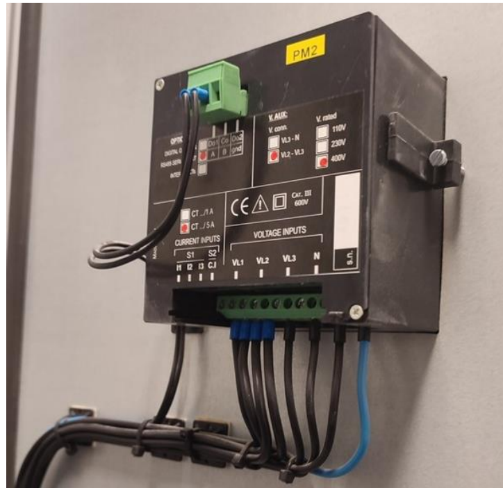
Joonis 2.1 Peajaotuskilbi ukssel asuv võrguanalüsaator
