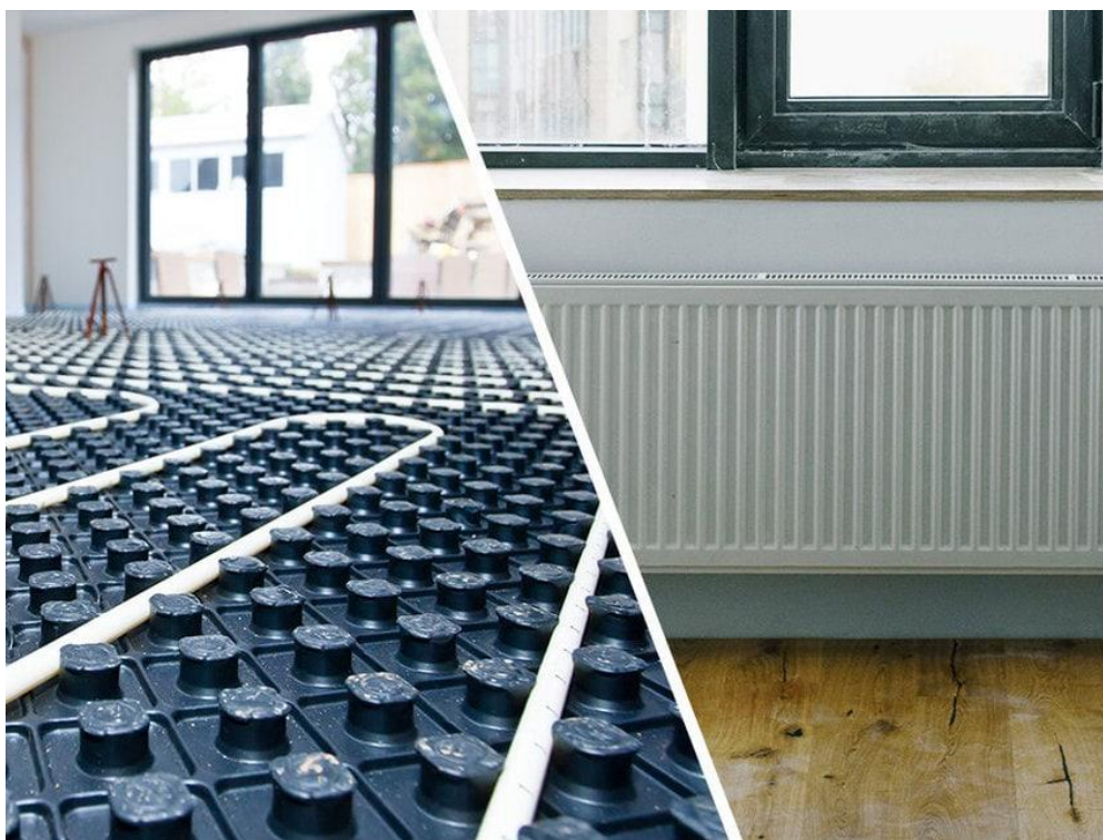
Joonis 4.3 Põrandaalused küttevõetorud vs radiaatorid [31]
