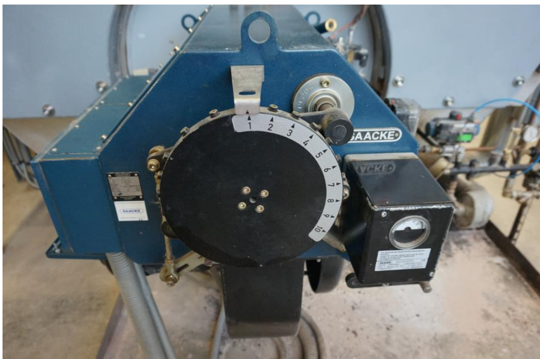
Joonis 6.2 Saarioineni katla õlipõleti Saacke SKVJ25 (allikas: Filter AS erakogu)
