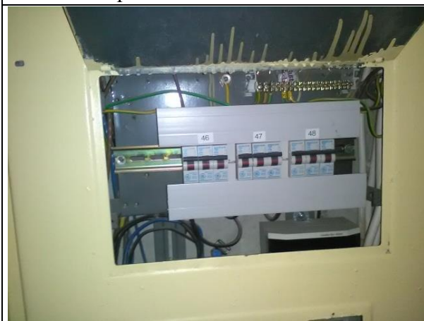
Pilt 7. Korruse elektrikilp
